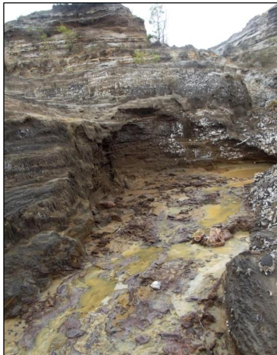
Figura 25: Presencia de lixiviados en la presa de jales (Foto propia, 2012).
