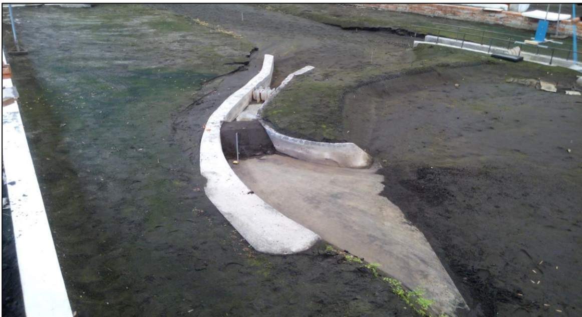
Figura 3.3 Dique de arena empleado para clausurar el canal de la margen izquierda
