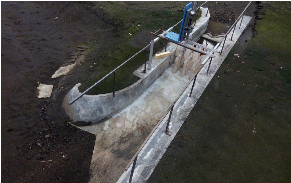
Figura 3.1 Canal de la margen derecha correspondiente al modelo físico de la estructura El Macayo
