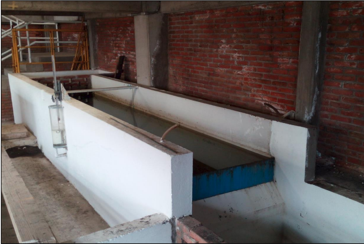
Figura 3.5 Canal de acceso al vertedor y ubicación de limnómetro utilizado para aforos
