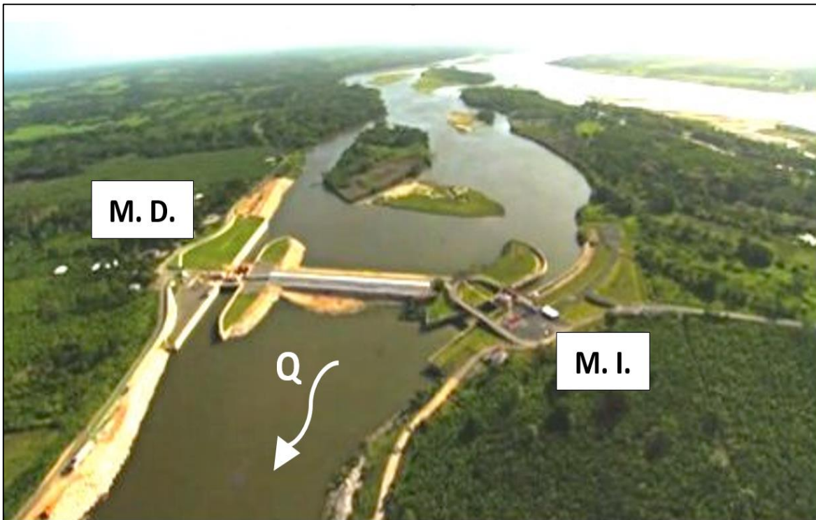
Figura 4.2 Canales de descarga de la estructura de control El Macayo
