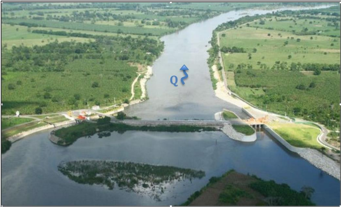
Figura 1.2 Estructura de control El Macayo
