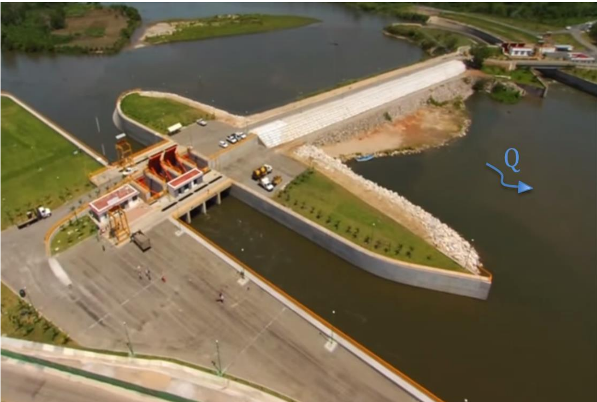
Figura 6.1 Canal de la margen derecha, El Macayo
