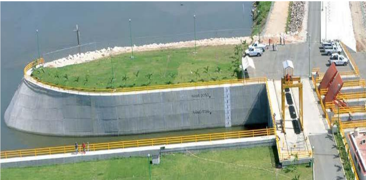
Figura 3.8 Sitio donde se localiza la escala del canal de la margen derecha (prototipo)
