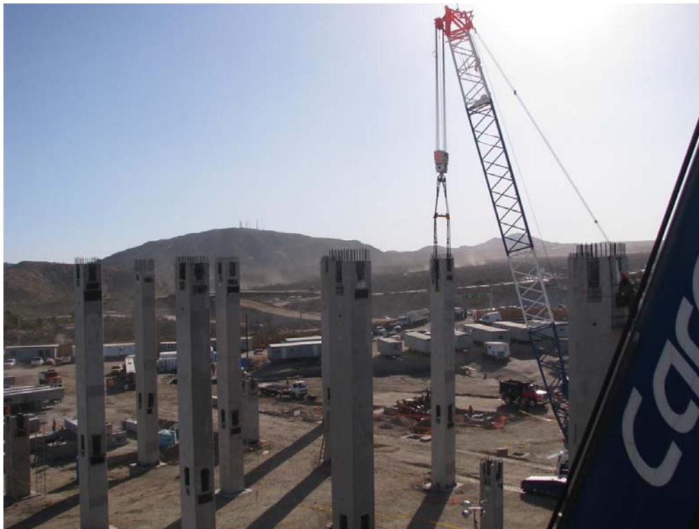
Fig. 9.1 Montaje de columnas obedeciendo cierta secuencia preestablecida.
