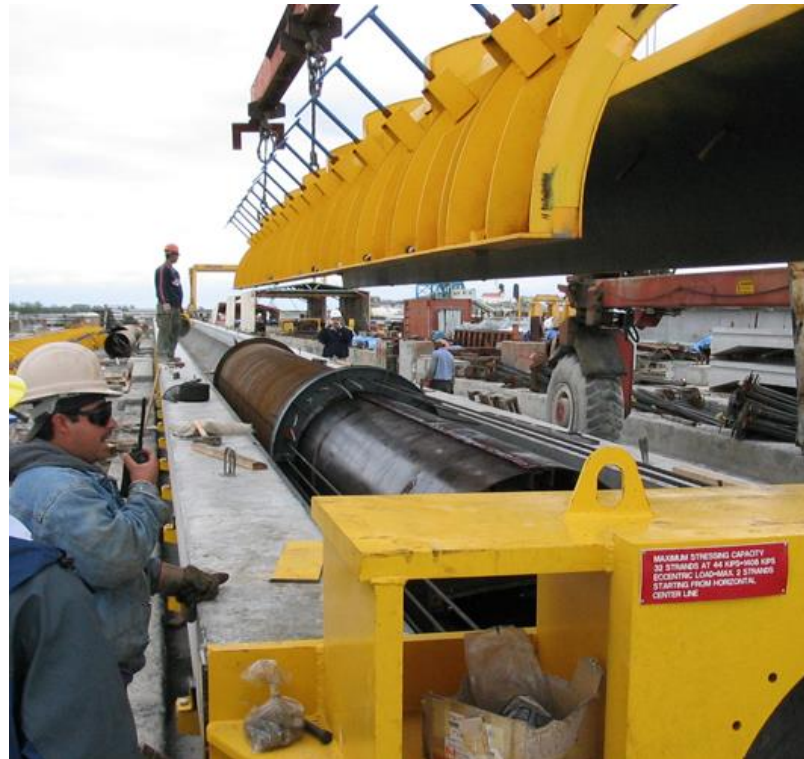
Fig. 6.18. Sistema de cimbra autotensable
