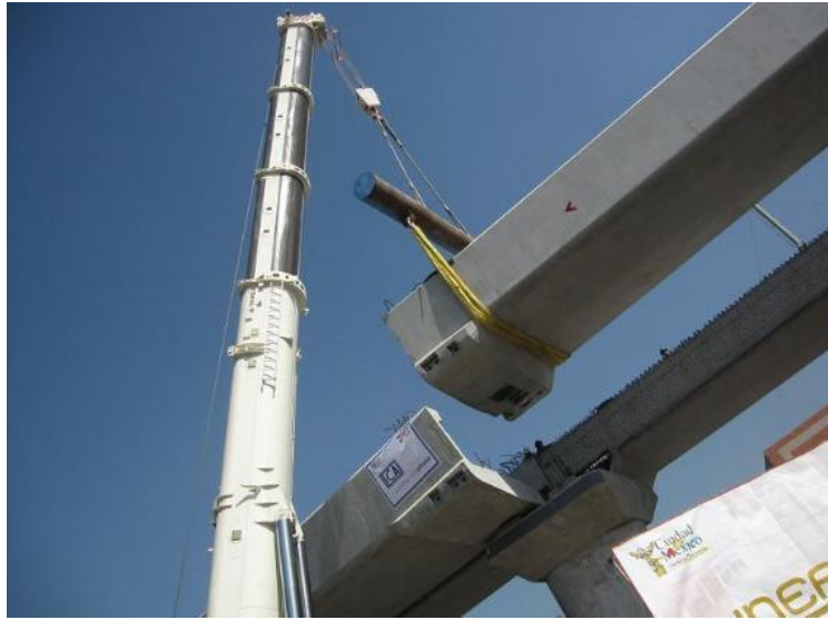
Fig. 9.7b Balancín metálico de gran capacidad
