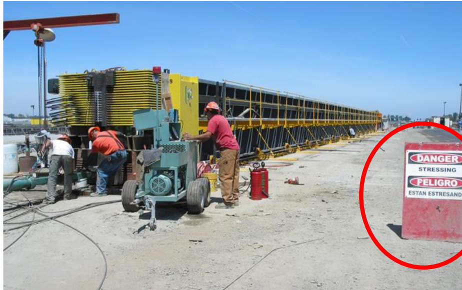
Figura 3.b Anuncio que indica que se está efectuando la operación de tensado en el área.
