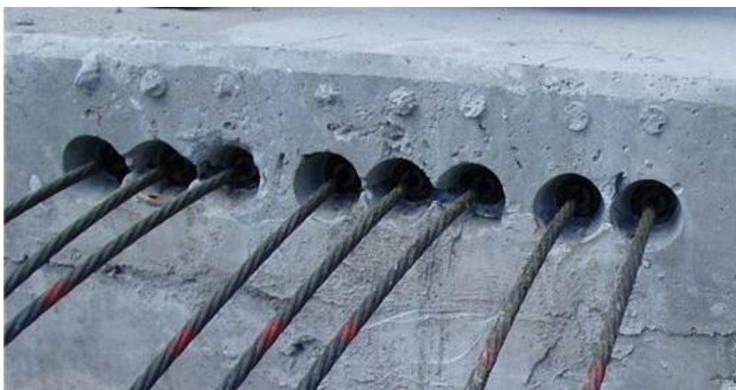
Fig. 6.26. Torones que pueden ser recortados hacia el interior del concreto.
