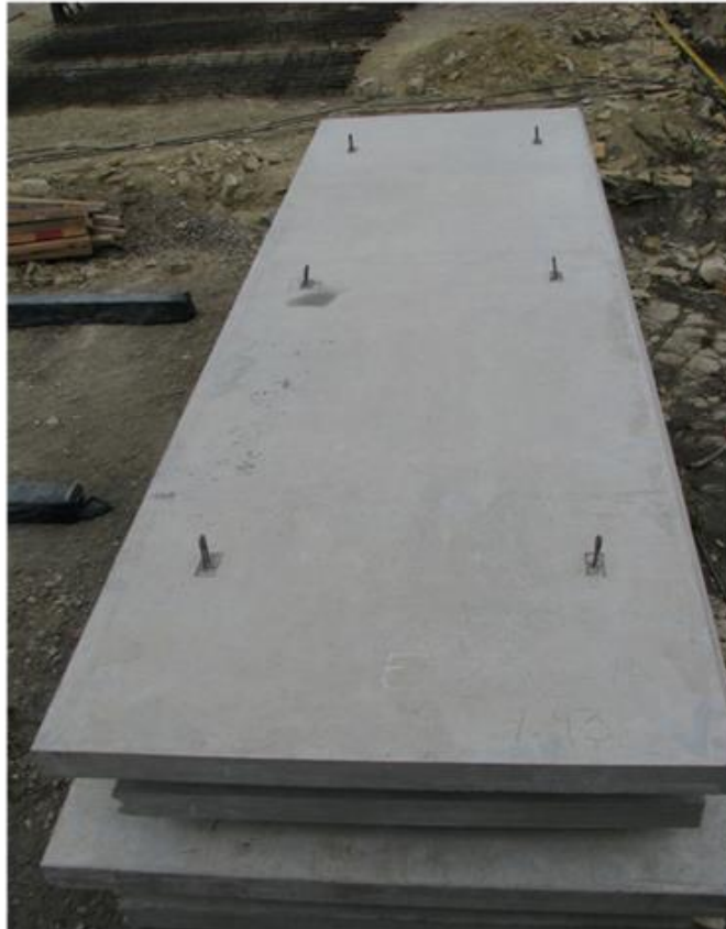
Figura 4.14 Muros prefabricados en posición horizontal
