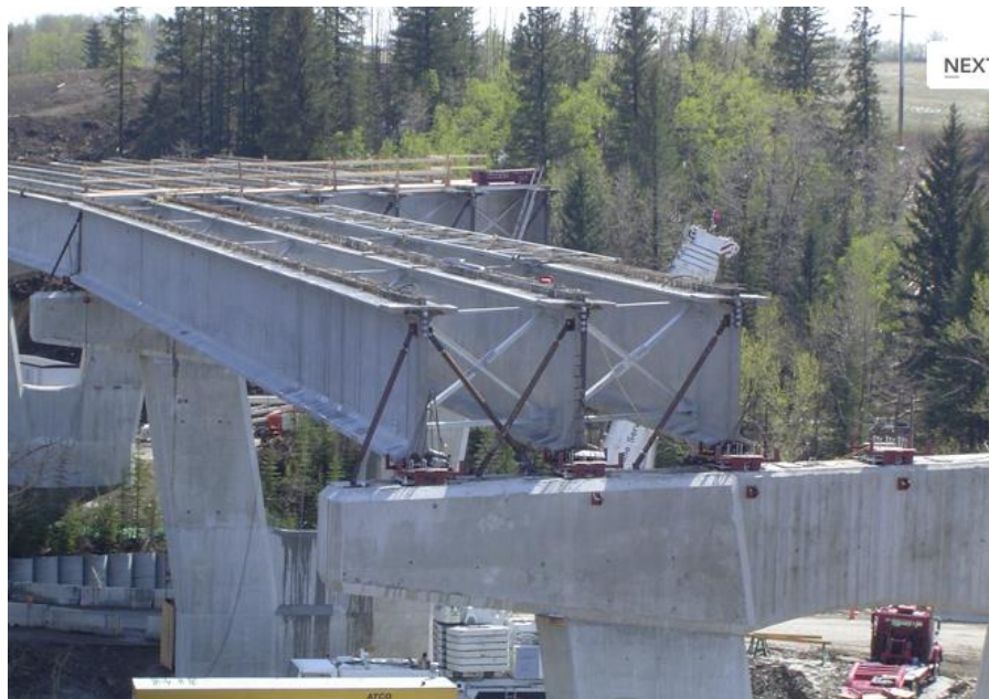
Fig. 9.16 Sujeción lateral provisional de traveses
