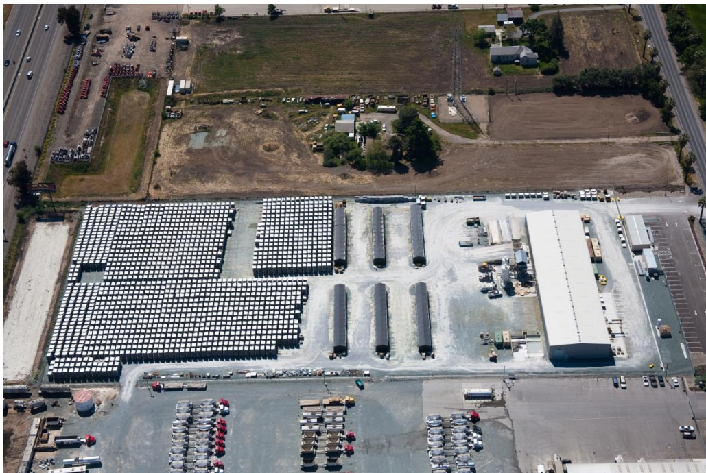
Figura 2.1 Planta de prefabricación de dovelas, Stockton, CA, EUA.
