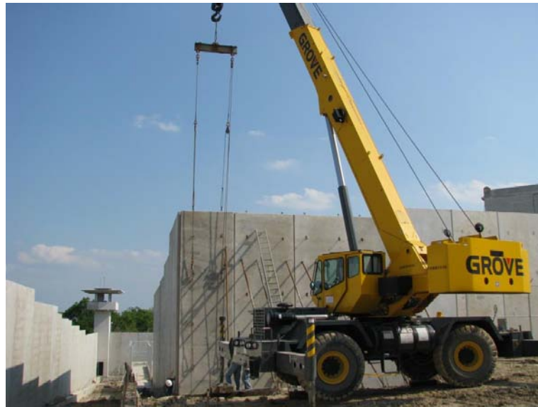
Fig. 9.2 Grúa hidráulica todo terreno montando muros prefabricados
