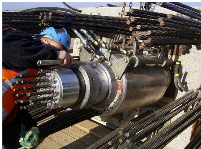
Fig. 6.23. Proceso de tensado con gato multitorón.
