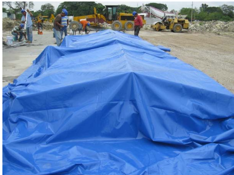
Figura 4.2 Lona térmica cubriendo muros prefabricados
