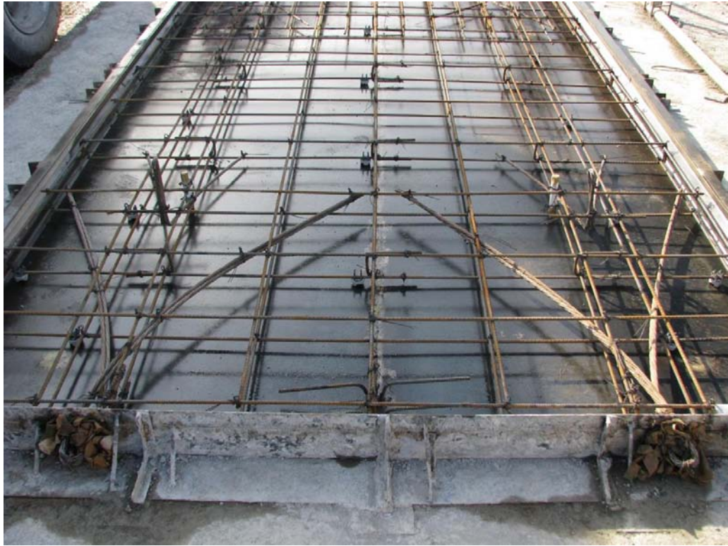
Figura 4.16 Ojales de izaje previos al colado en un muro.
