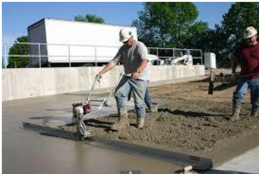
Figura 5.6 Regla de vibrado (usada en superficies con poco peralte) y muros prefabricados.
