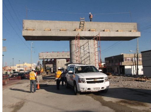
b) Pila 5 reconstruida
