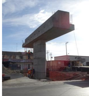
a) Pila 4 en buen estado
