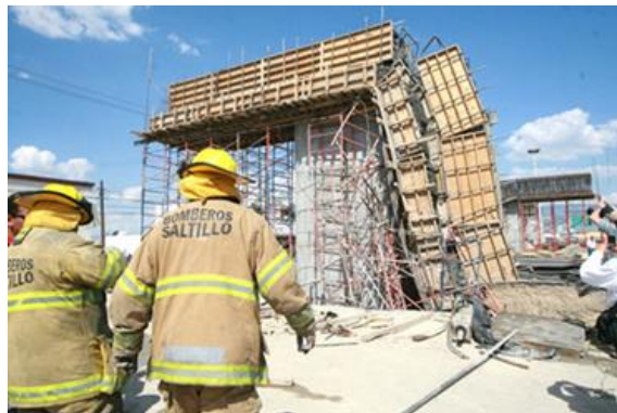
Colapso parcial del cabezal en una pila del PSV. LEA- Abasolo-Lafragua (Gómez, et al.,2014)
