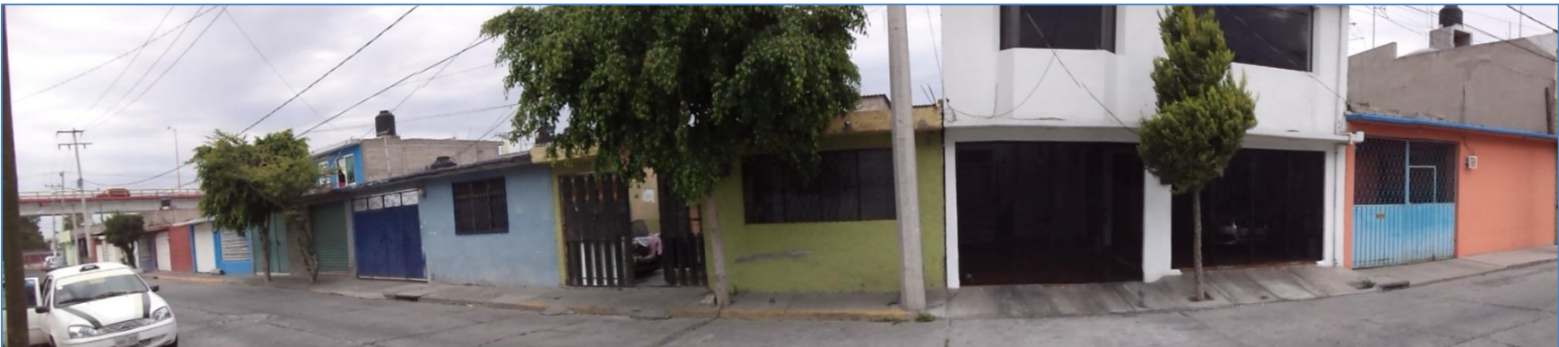
Vivienda unifamiliar, un nivel, misma relación vano-macizo, algunos lotes se han modificado a dos niveles. Calle Ajusco. Paramento B.
