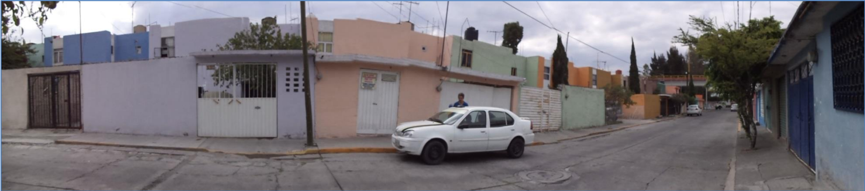
Vivienda unifamiliar, dos niveles, misma relación vano-macizo. Calle Ajusco, Paramento A.
