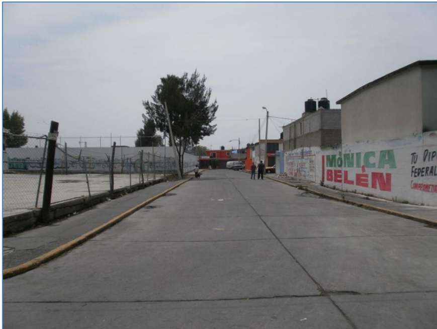
Imagen 66. Deterioro y obsolescencia de la imagen urbana.
