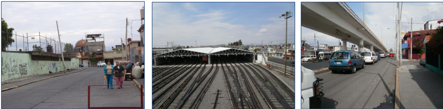
Imagen 28. La cúpula del templo resulta un hito importante en el Fraccionamiento, sin embargo, la mala imagen de las calles y poca iluminación inhiben la continuidad del paseante. Los talleres del STC Metro y las vías son una barrera física importante que divide a la colonia. Los puentes vehiculares han afectado la imagen de Ciudad Azteca, principalmente por la poca visibilidad y continuidad para el peatón.
