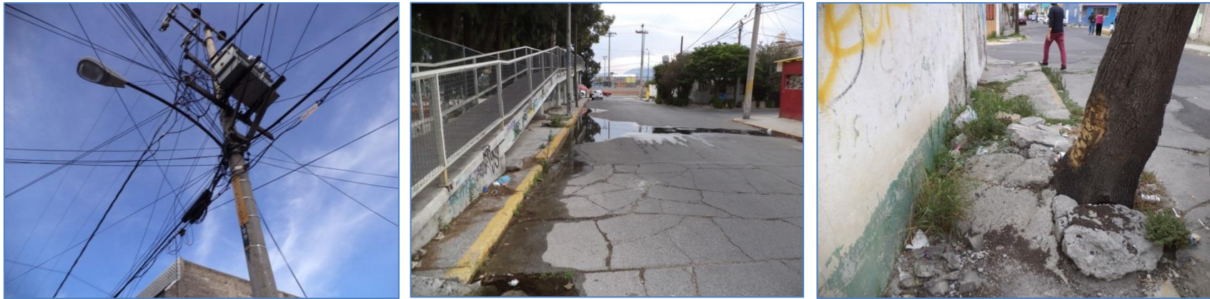
Imagen 34. La imagen urbana del espacio público evidencia los problemas de la infraestructura de la colonia.
