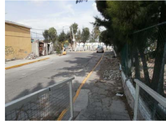
Imagen 6. Estado actual de banqueta próxima a parque.
