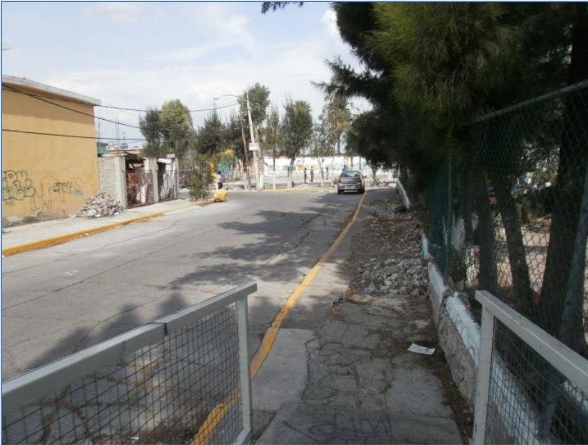
Imagen 68. Obstáculos, deterioro de la vialidad.
