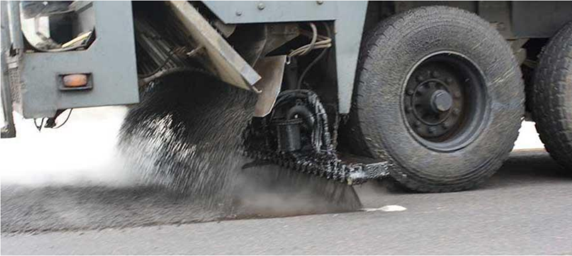
Imagen 2.5 Aplicación sincronizada de Emulsión Asfáltica y Sello.
