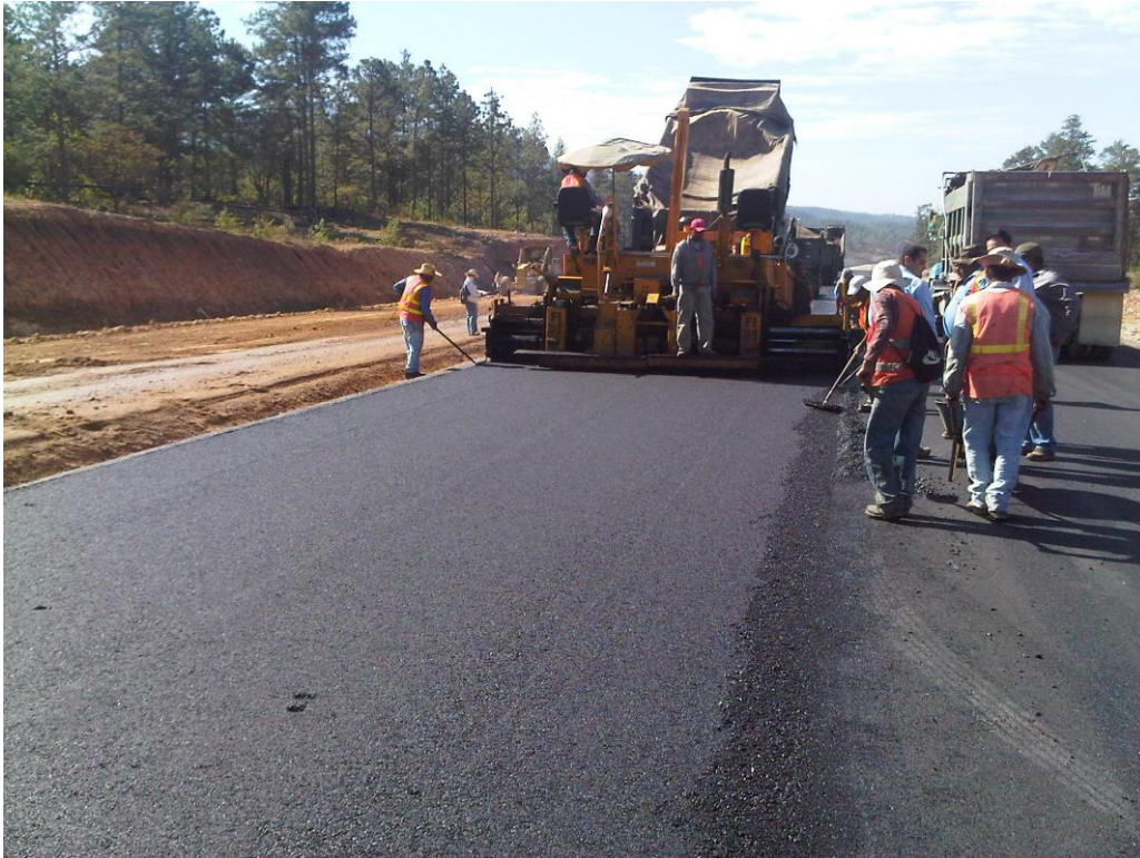
Imagen 2.2 Tendido de Mezcla Asfáltica en Caliente usando entendedor Finisher.
