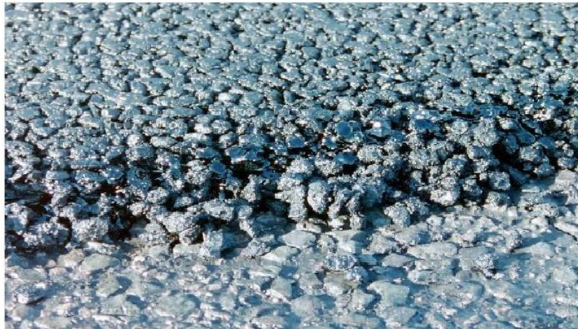
Imagen 2.6 Compactación y Textura de Mezcla Asfáltica SMA.
