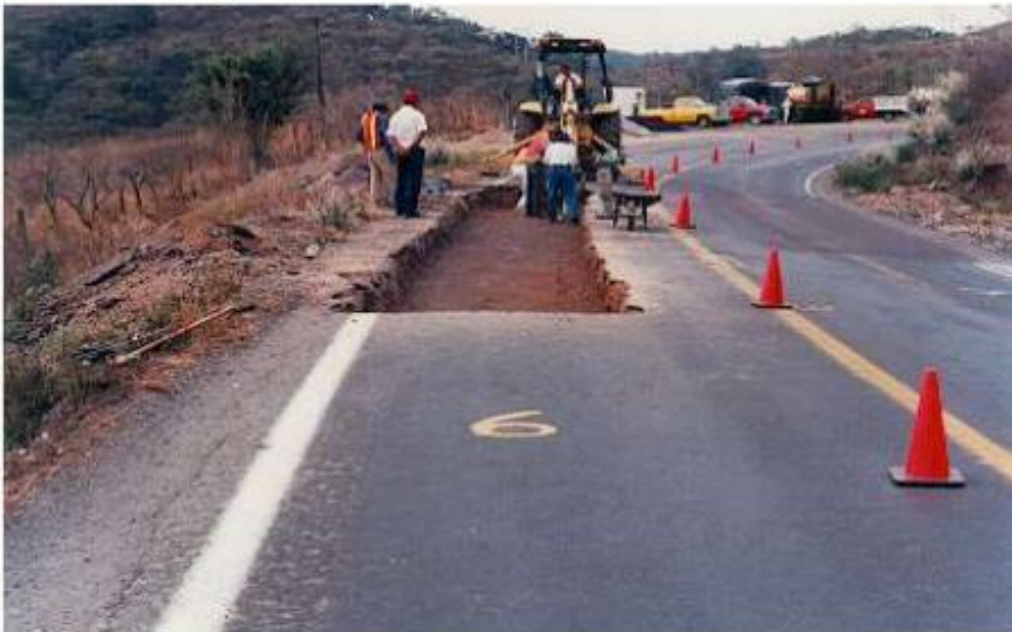
Imagen 2.21 Bacheo Profundo para trabajos de Reconstrucción de Tramos.
