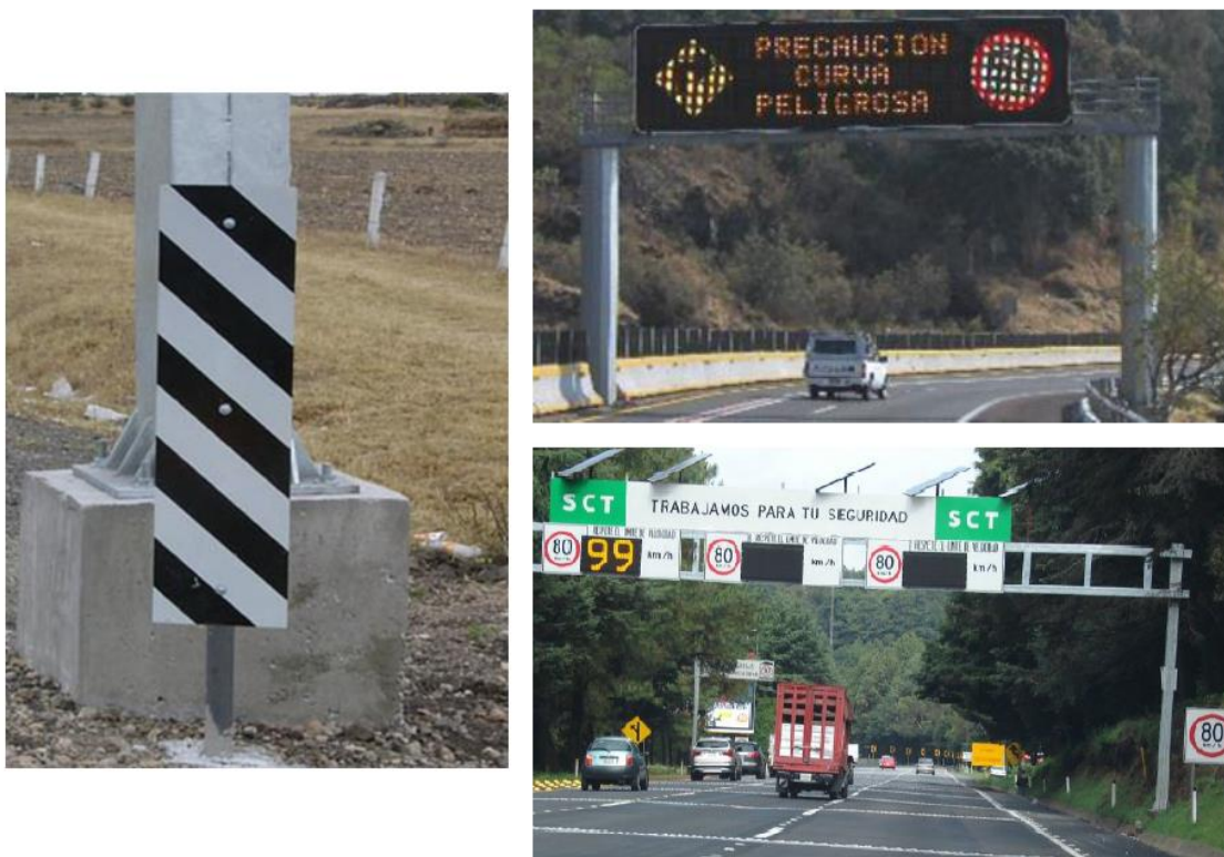
Imagen 5.13 Ejemplo de Señales Diversas (Imagen Izquierda: Indicador de Obstáculos, Imágenes Derecha: Señales de Mensaje Cambiable). 10
