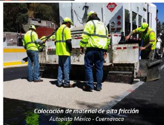
Imagen 2.26 Trabajos de Mantenimiento en Autopistas operadas por CAPUFE.
