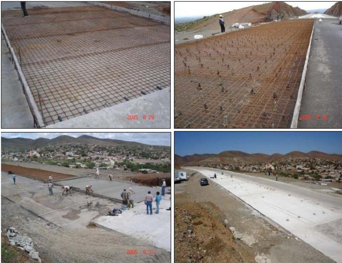
Imagen 2.13 Libramiento Osiris – Morelos en Zacatecas, el cual implemento Losas de Concreto Hidráulico con Refuerzo Continuo en su construcción.
