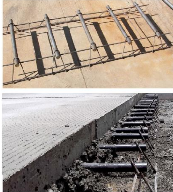
Imagen 2.12 Distribución de carga en Pasajuntas y colocación.
