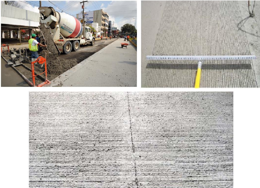
Imagen 4.6 Colado y Texturizado del Concreto Hidráulico 6 .
