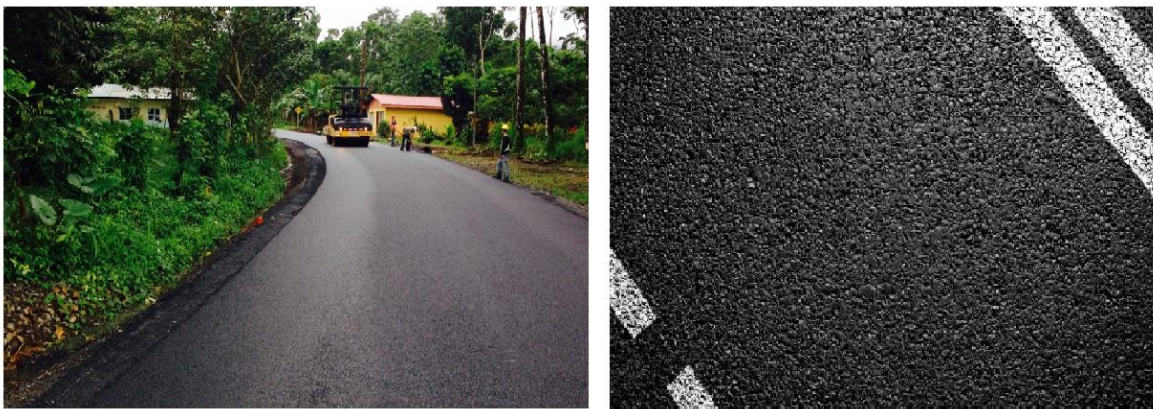
Imagen 4.5 Compactación y acabado de carpeta asfáltica.
