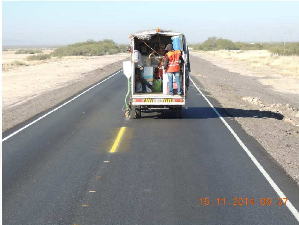
Fotografía 6.10 Dosificación de Microesfera.
