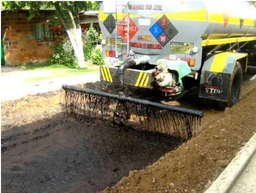
Imagen 2.9 Base estabilizada con Emulsión Asfáltica.
