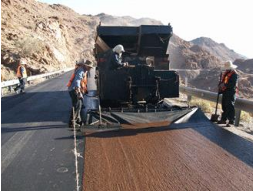
Imagen 2.4 Aplicación de Mortero Asfáltico.
