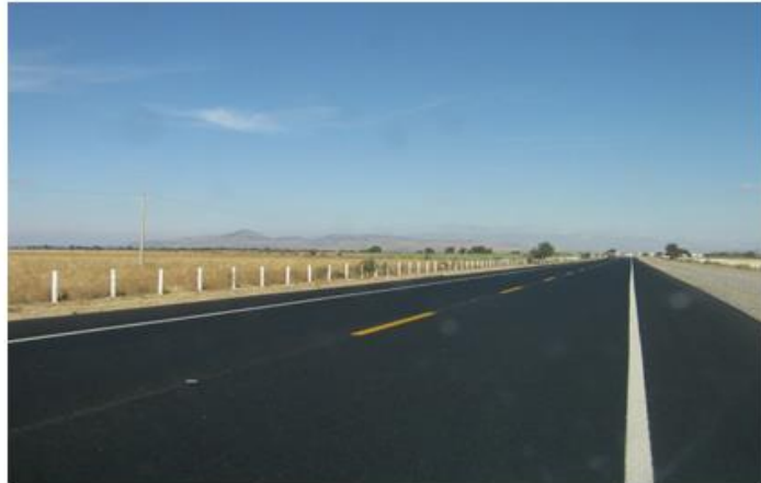
Imagen 2.7 Tendido y Acabado de carpeta CASA.
