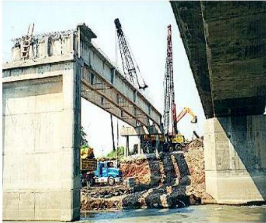
Imagen 2.22 Sustitución de Superestructura para trabajos de Reconstrucción de Puentes.
