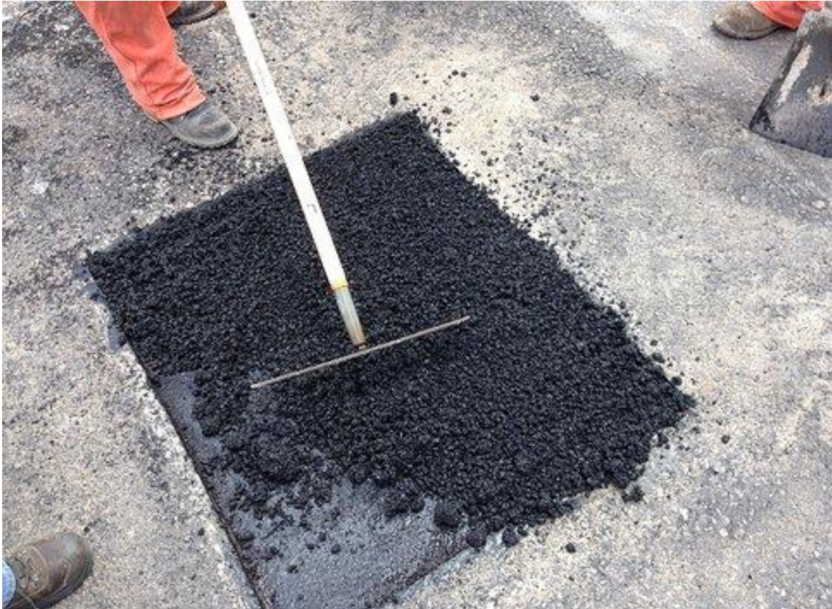
Imagen 2.3 Bacheo mediante Mezcla Asfáltica en Frío.
