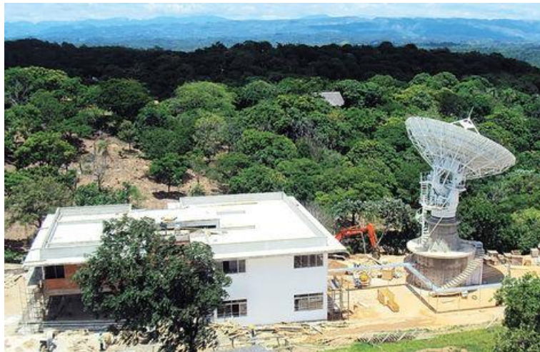
Figura 2-10 Estación terrena de apoyo para control y monitoreo satelital [52]
