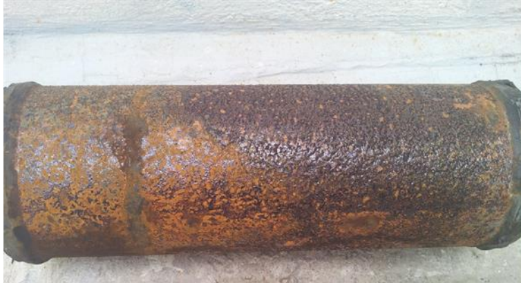
Fig. 55 Ducto después de la prueba a presión 500 psi.
