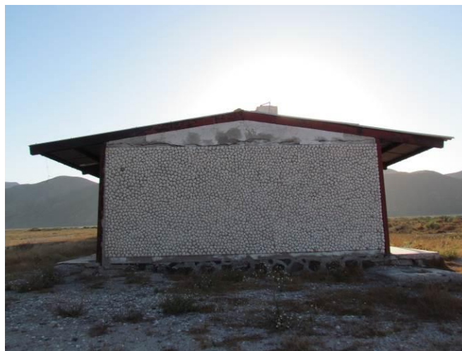
Figura 4.38 Construcción de la escuela primaria “Artículo 123” en Isla El Carmen, cuyos muros están recubiertos de concha.
