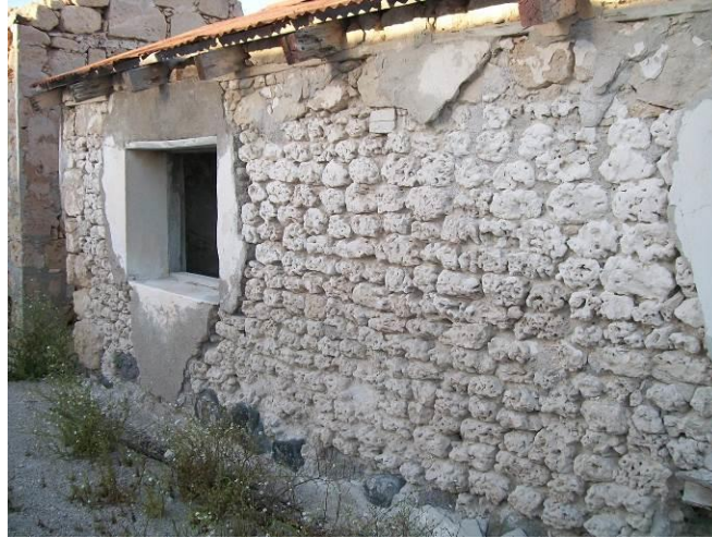
Figura 4.40 Muchas de las antiguas viviendas de los trabajadores están recubiertas de risco, un tipo de coral extraído del litoral isleño. Fuente: Trabajo de campo, abril de 2013.
