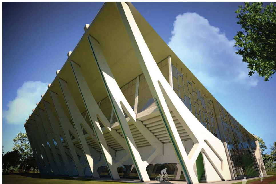
14.8. Vista sur-oeste del proyecto
