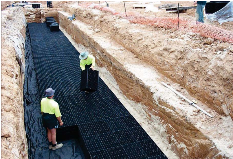
11.6. Ejemplo de acomodo de módulos Atlantis matrix
