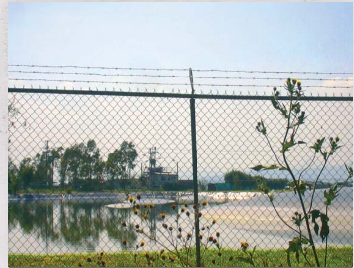
5.14. Vista de la planta tratadora de agua Texcoco
