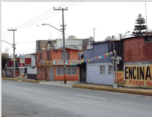
8.5. Muestra el estado actual de la imagen urbana en las colonias aledañas.
