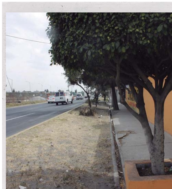
7.2. Un caso de una banqueta de más de dos metros de ancho, pero aun así inadecuada para el tránsito peatonal
