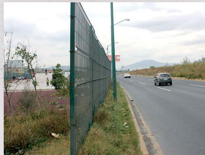
4.8. Una inexistente adecuación para que los peatones puedan acceder al lugar de recreación
