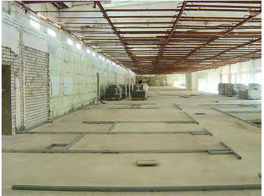
**Imagen 58.** montaje de muros prefabricados y primeras instalaciones.
