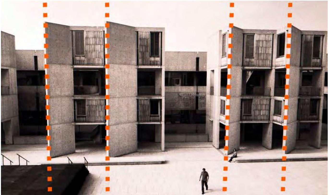
*Imagen 43. imagen del área de oficinas, con orientación poniente, y estructura de concreto aparente como parasoles.*
