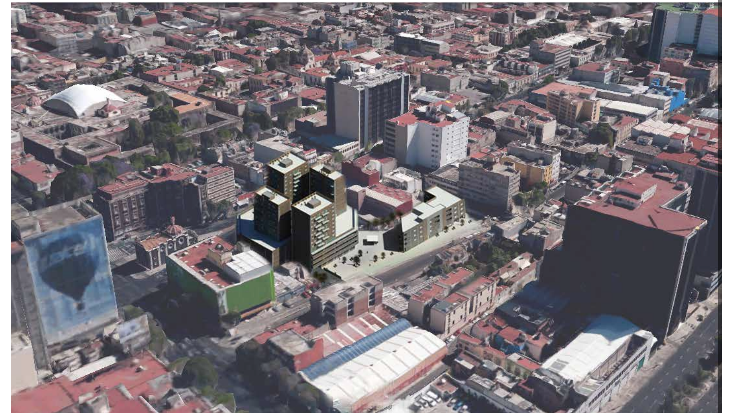
Imagen 2.2.22.- (Arriba) Conjunto Multifuncional y habitacional Salto del Agua en el contexto urbano del perímetro B del centro histórico, vista hacia el sur. Imagen 2.2.23.- (Abajo) Conjunto Multifuncional y habitacional Salto del Agua en el contexto urbano del perímetro B del centro histórico, vista hacia el norte.
