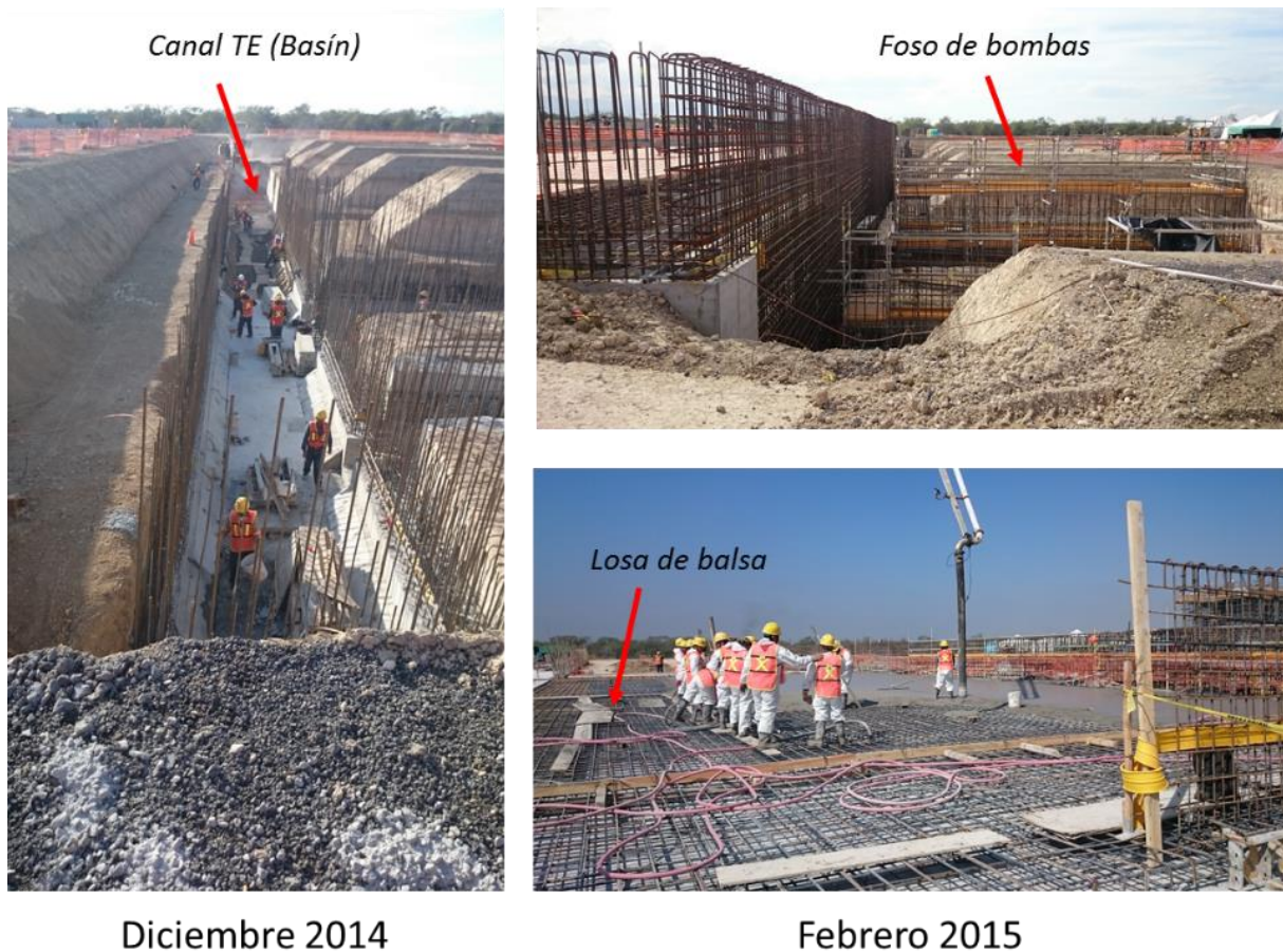
Figura 36 Fundaciones Torre de Enfriamiento 47
