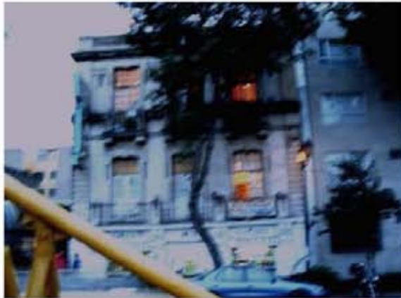
Edificio de vivienda catalogado por el INAH.
