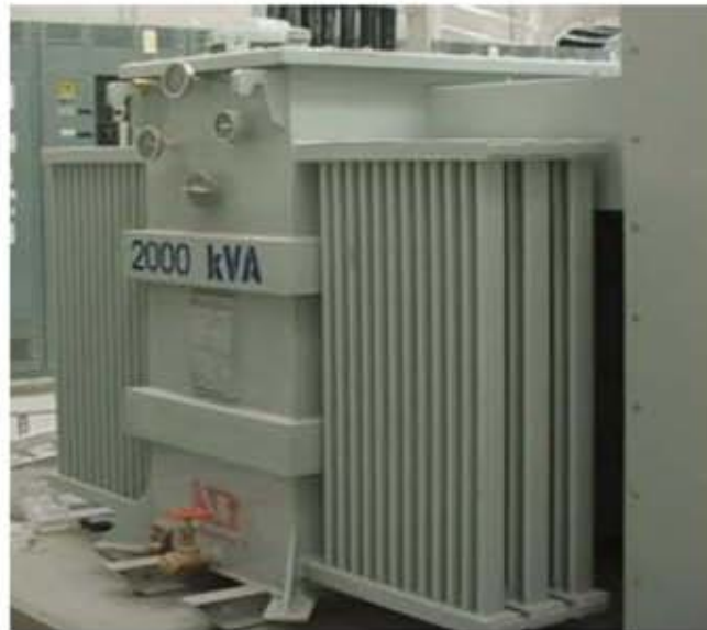
Transformador tipo pedestal marca: DELTA o similar
