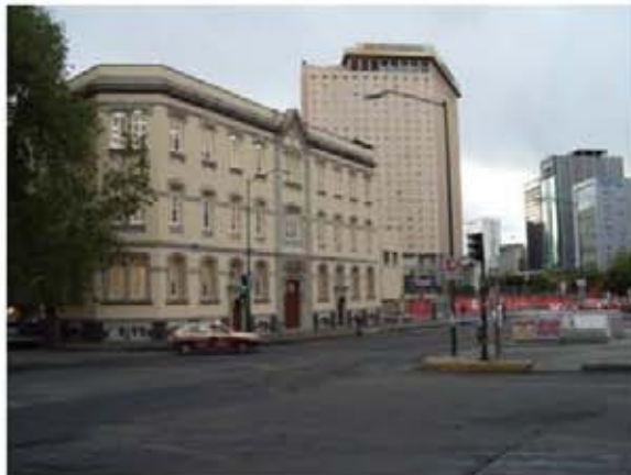
Edificio de la Auditoria superior de la federación, catalogado por el INAH.
