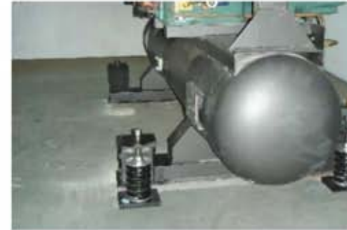
Aislantes de vibración Marca: Abbix o similar
