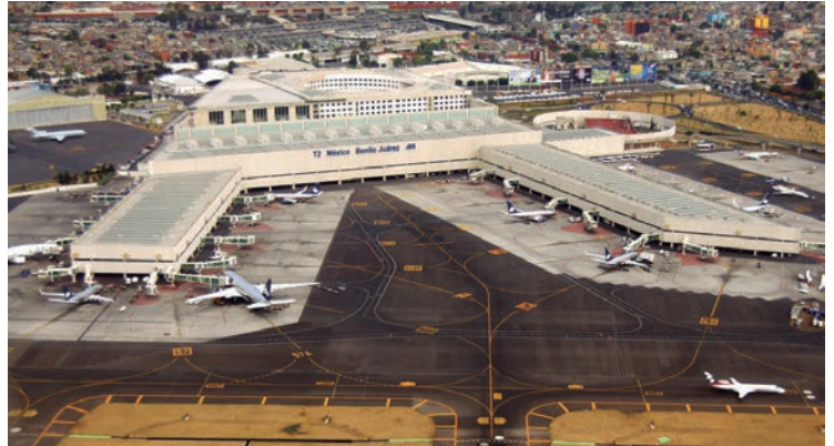
Foto aérea Terminal 2 del Aeropuerto Internacional Benito Juarz de la Ciudad de México, 2009
