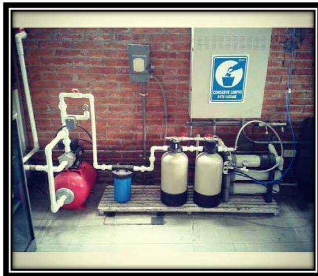
Figura 21. Equipo de Osmosis inversa, planta solar UNAM
