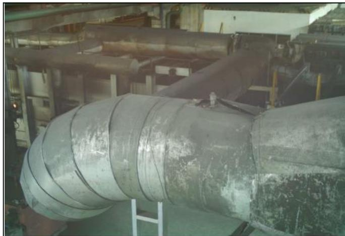
Fig. 1.18 Tubería de aire de combustión de un horno.
