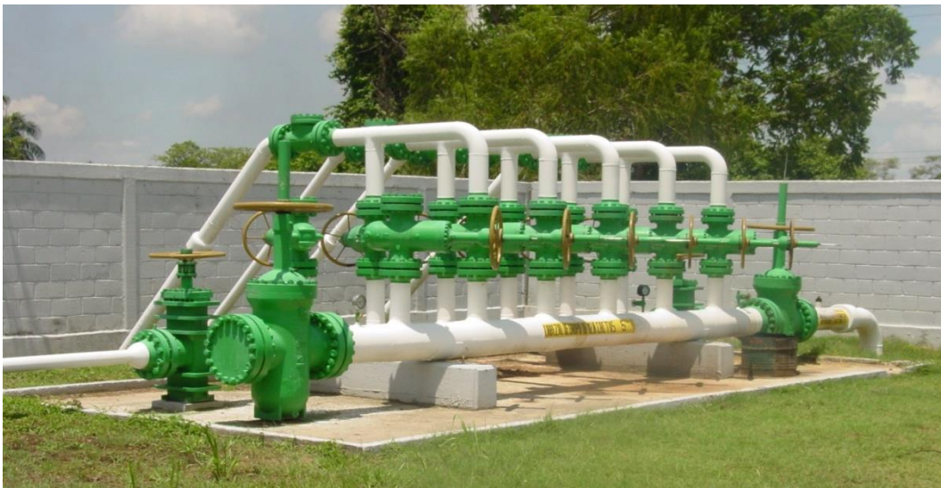
Figura I.1 Cabezal foráneo de recolección
