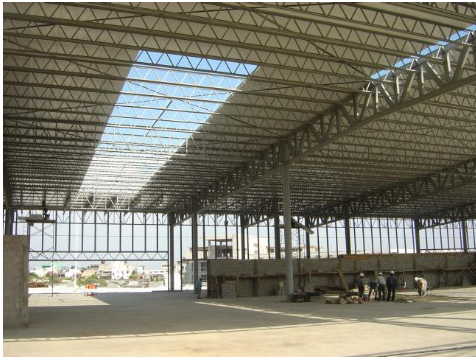
Figura 33 Corte en cubierta para creación de lucernario visto desde el interior de la tienda.
