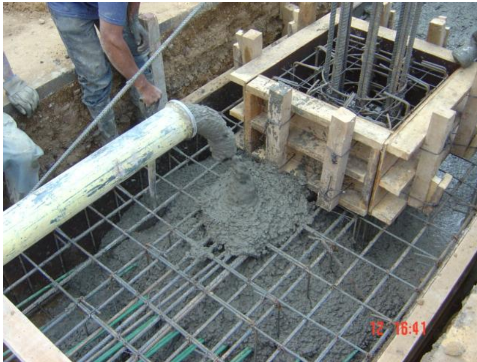
Figura 20 Colocación de concreto en zapata de cimentación. Se observa también cable de presfuerzo en la posición definitiva dentro de la zapata.
