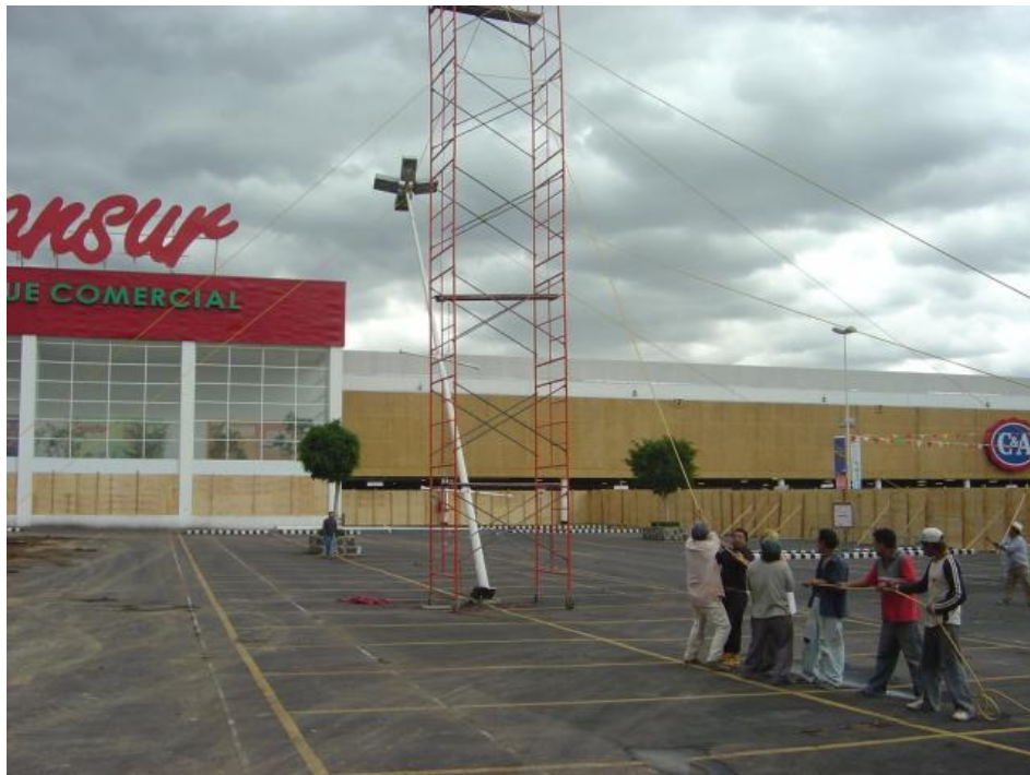
Figura 15 Trabajos preliminares. Desmontaje de luminaria en estacionamiento.
