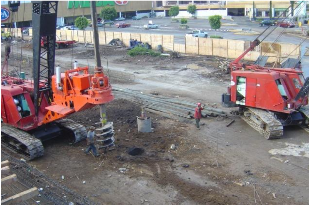
Figura 23 Equipo utilizado en la perforación de pilas en cimentación de cuerpo “B” visto desde losa de concreto del cuerpo “A”.
