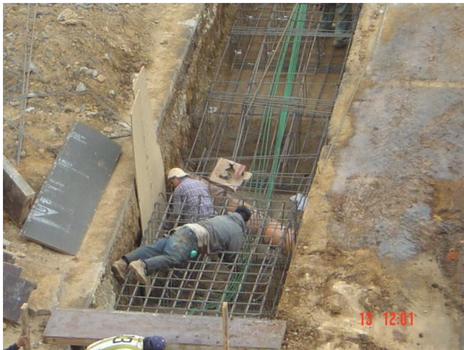
Figura 19. Colocación de cable de presfuerzo en cimentación.
