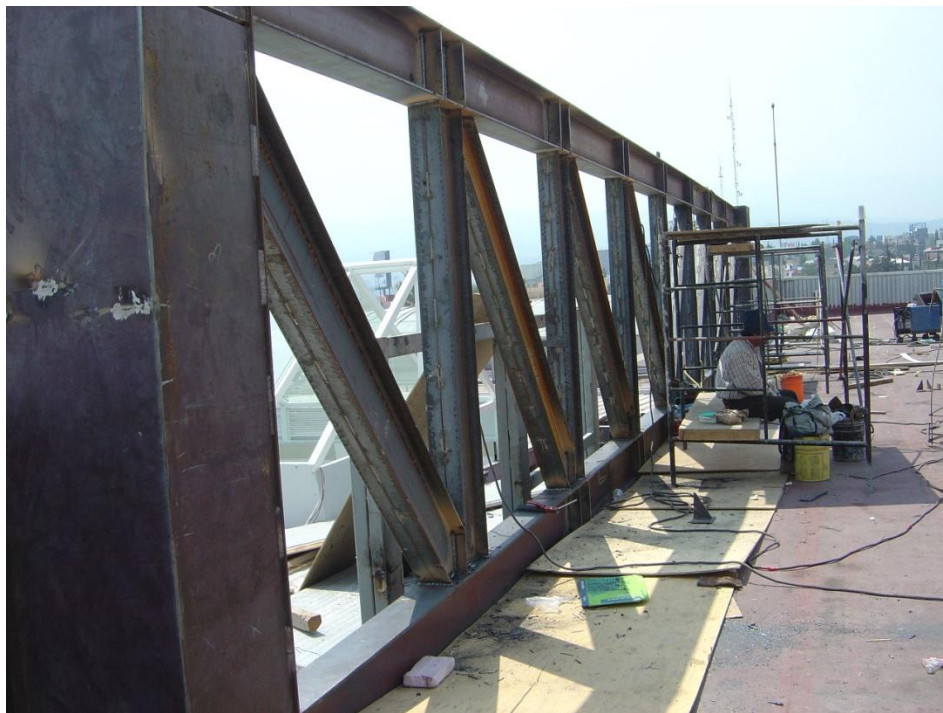
Figura 27 Armadura creada para poder demoler columna en pasillo interior de tienda.
