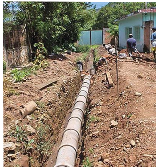
Suministro y colocación de drenaje en la zona de la quebrada.
