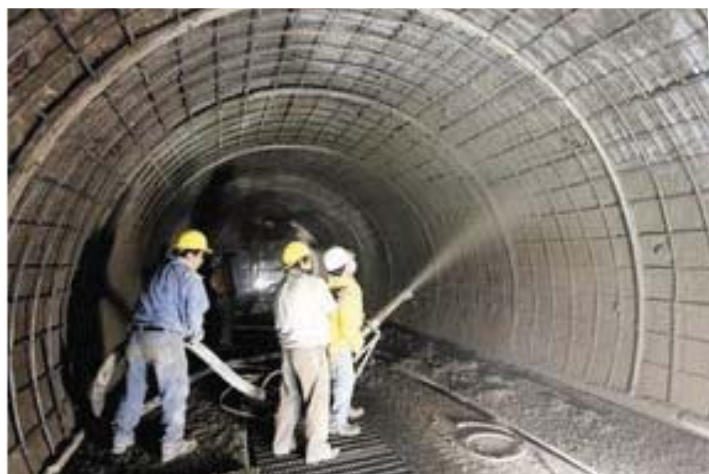
Drenaje subterráneo aplicación de concreto por bombeo.
