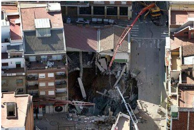
*Figura 1.2 Colapso del túnel de Línea 5 del Metro de Barcelona*
