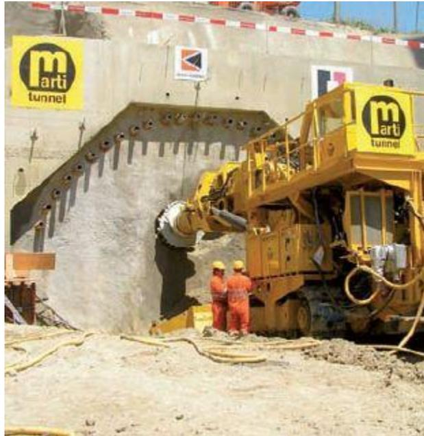
*Figura 1.7 Máquina rozadora*
