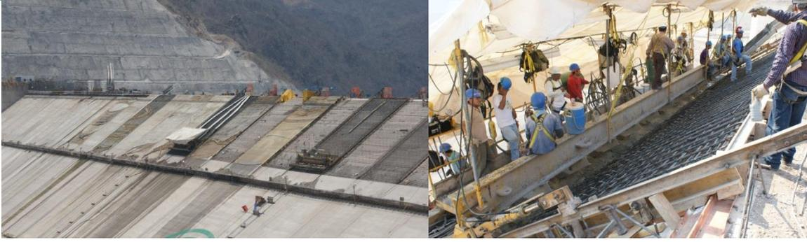
Figura 5-61 Losas de Cara de Concreto (cimbra deslizante)
