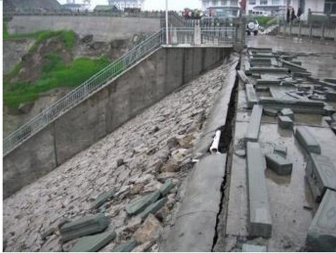
Figura 6-3 Daños en la cresta (bordo aguas abajo) de la presa Zipingpu ECCC (Fotografía cortesía ZepingXu, China) Tomadas de la presentación del Dr. Martin Wieland en el "The First International Symposium on Rockfill Dams", en Chengdu, China del 18 -21 de octubre 2009
