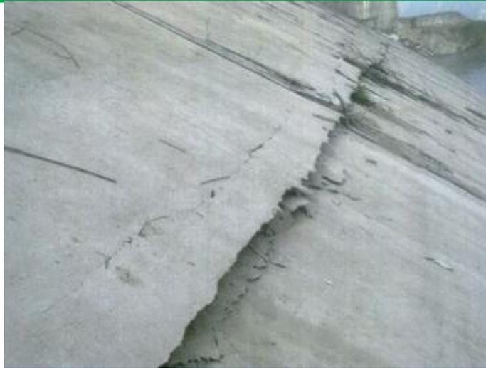
Figura 6-1 Daños en la cara de concreto de la presa Zipingpu ECCC (Fotografía cortesía ZepingXu, China) Tomadas de la presentación del Dr. Martin Wieland en el "The First International Symposium on Rockfill Dams", en Chengdu, China del 18 -21 de octubre 2009
