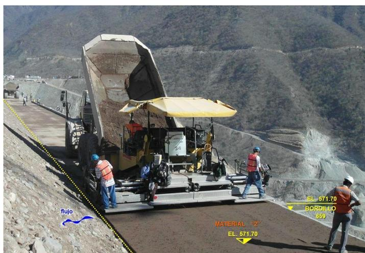
Figura 5-67 Colocación de Material 2
