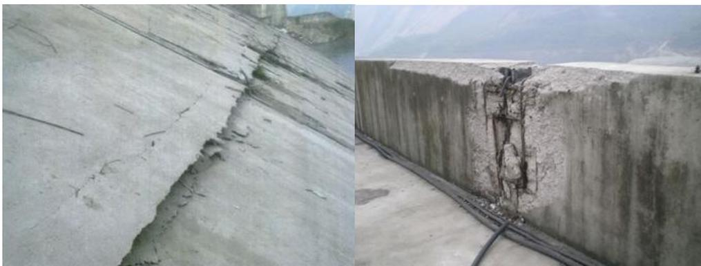
Figura 2-5 (i) Daños en la cara de concreto (d) Daños en el parapeto de la presa Zipingpu
