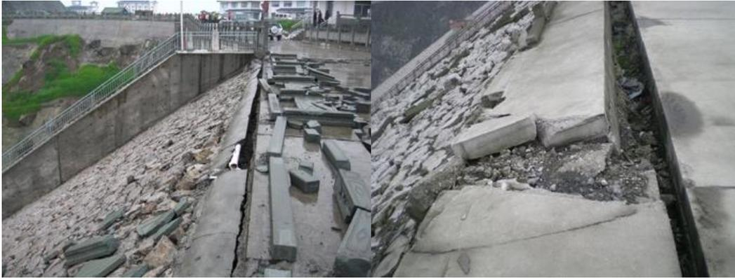
Figura 2-6 Presa Zipingpu: Daños en la cresta (vista aguas abajo)
