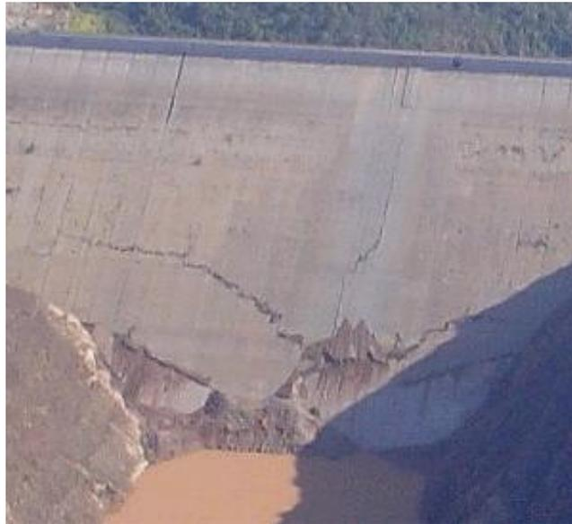
Figura 4-17 Fracturamiento en la presa "Campos Novos" en Brasil presentando durante su primer llenado (2006)
