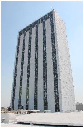
Figura 4. Fachada Sur de la torre del CCUT
