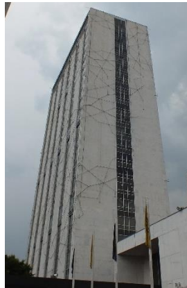
Figura 5. Vista oriente de la torre del CCUT
