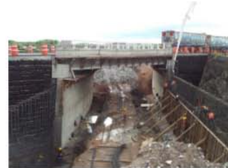
HABILITANDO ACERO PARA ESTRIBOS
