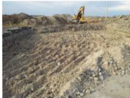
TRABAJOS DE EXCAVACIÓN
