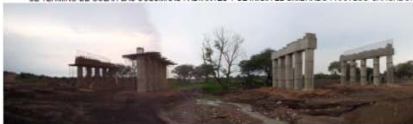
SE ESTA TRABAJANDO EN LOS CARGADORES DE LADO EL DESPERDICIO
