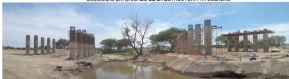
SE TERMINO DE COLAR LAS COLUMNAS FALTANTES Y SE INICIA EL CIMBRADO PARA LOS CARGADORES
