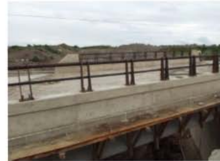
GUARNICIONES Y PARAPETOS INSTALADOS (FALTA PINTURA)
