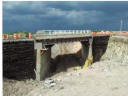
EXCAVACIÓN EN EL CUERPO DERECHO DE LA CARRETERA EL DESPERDICIO-LAGOS DE MORENO PARA SIGUIENTE SECCIÓN DEL DEPRIMIDO
