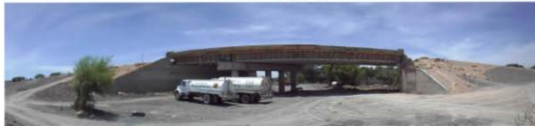
LOSAS Y GUARNICIONES COLADAS
