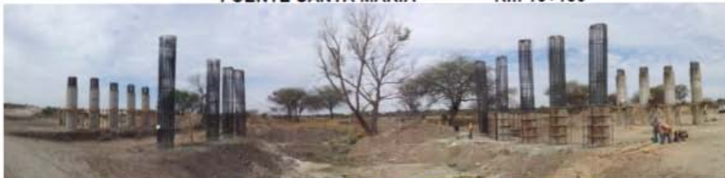
COLUMNAS EXTERIORES DE LA ESTRUCTURA YA COLADAS
