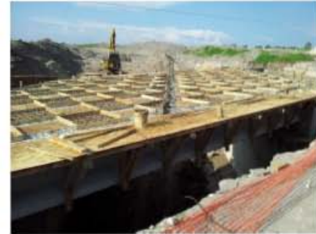
TRABES MONTADAS, DIAFRAGMAS COLADOS Y TRABAJANDO EN LA PREPARACION DE PHELUSAS
