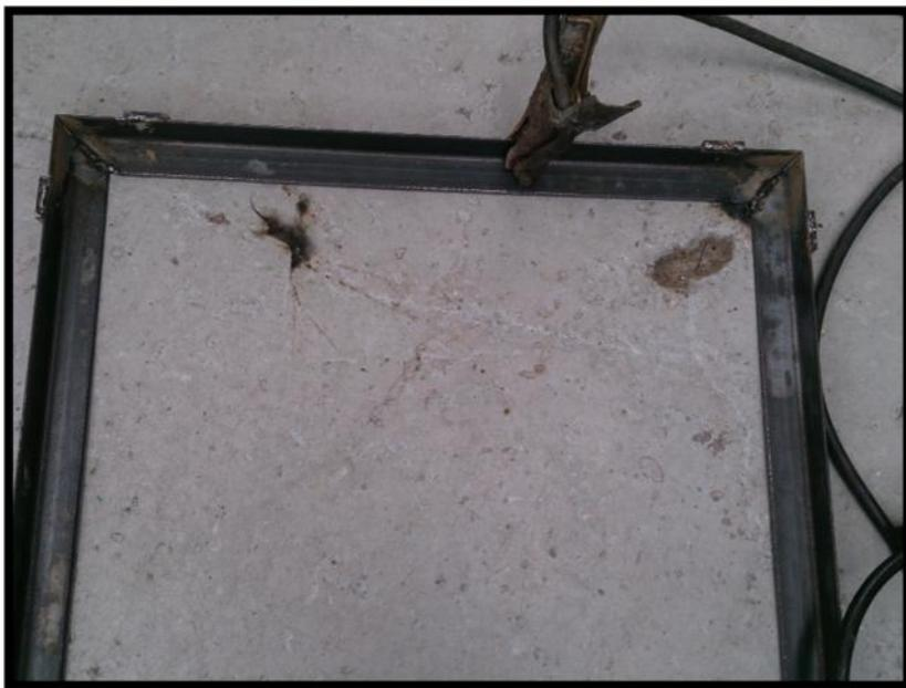
Se sueldan las plaquitas de barreno roscado al ángulo, procurando que estos queden concéntricos con los barrenos pasados de la estructura del ángulo.
