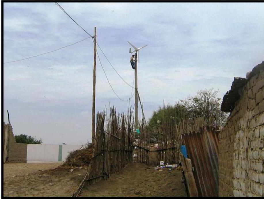
*Figura 2.2 Aerogenerador instalado en zonas rurales, generación 1KW.*
