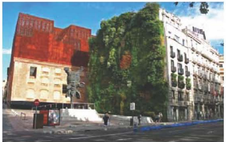
Remate de acero corten en las naves de ladrillo y el muro medianero vegetal.
