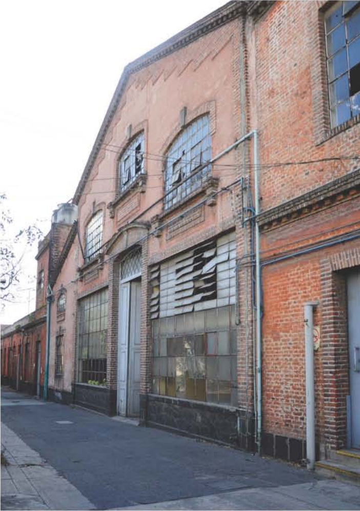
Fachada Art Deco
