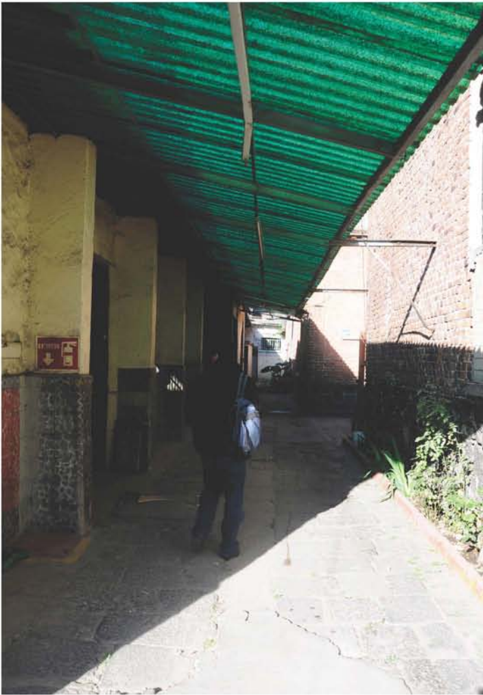
Pasillo de conexión entre edificios 2
