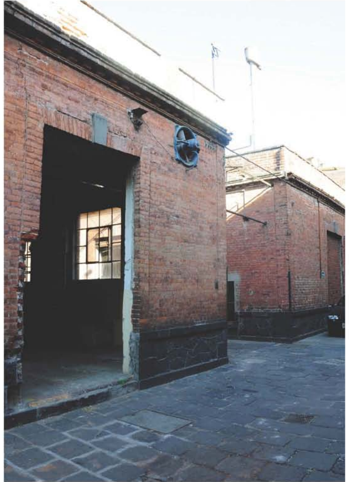
Accesos secundarias a las naves de la fábrica 3
