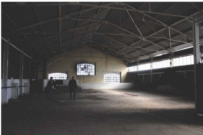
Nave principal de la fábrica
