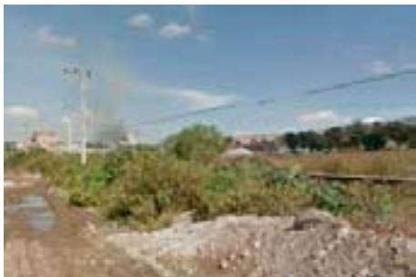
4. Acceso Prolongación Agricultores
