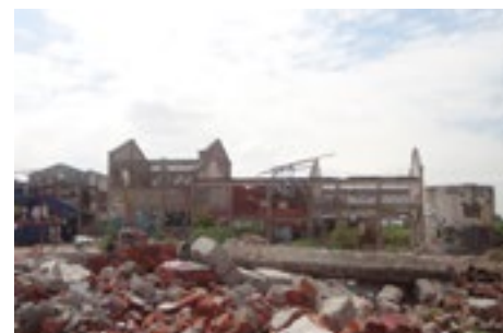
5. Escombros de demolición
