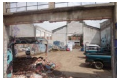
2. Utilización del predio como estacionamiento
