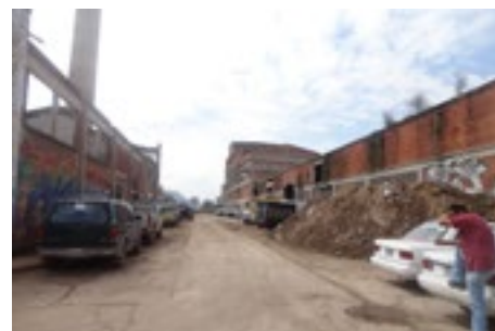
4. Predio abandonado y deteriorado
