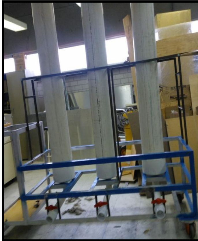
Figura 3.21. Tubos que componen el cuerpo principal del biodigestor colocados (Agosto, 2014).
