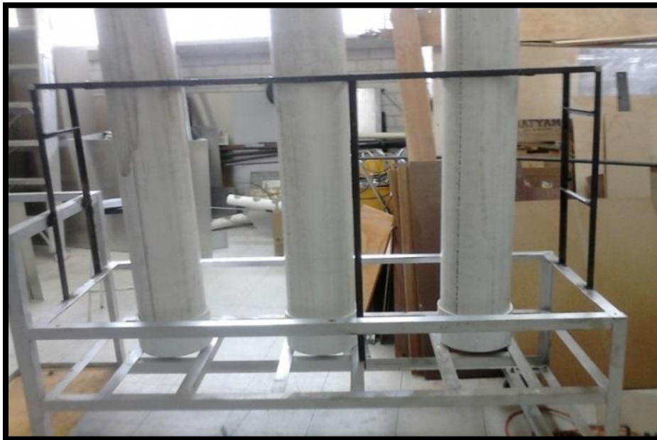
Figura 3.15. Barras de soporte terminadas (Agosto, 2014).
