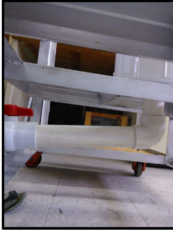
Figura 3.19 Inclínación en la instalación para desecho de lodos (Agosto, 2014).
