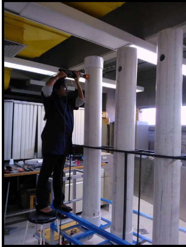
Figura 3.22. Realización de las perforaciones. (Agosto, 2014)
