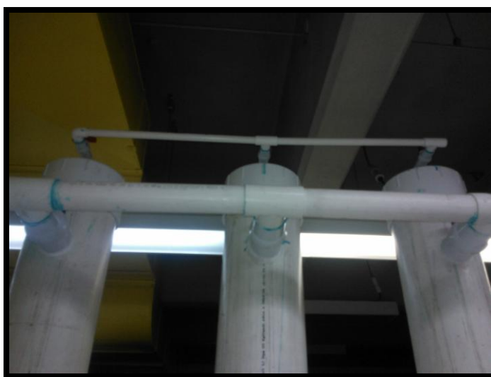
Figura 3.39. Instalación de gas primera parte (Septiembre 2014)
