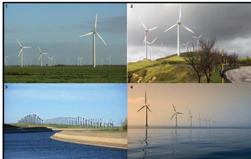
Figura 1.5. Plantas eoloeléctricas: 1) Tierra adentro en superficies planas; 2) Tierra adentro en lugares escarpados; 3) Cerca de la costa; 4) Fuera de la costa, (Jaramillo y Borjas; 2010).
