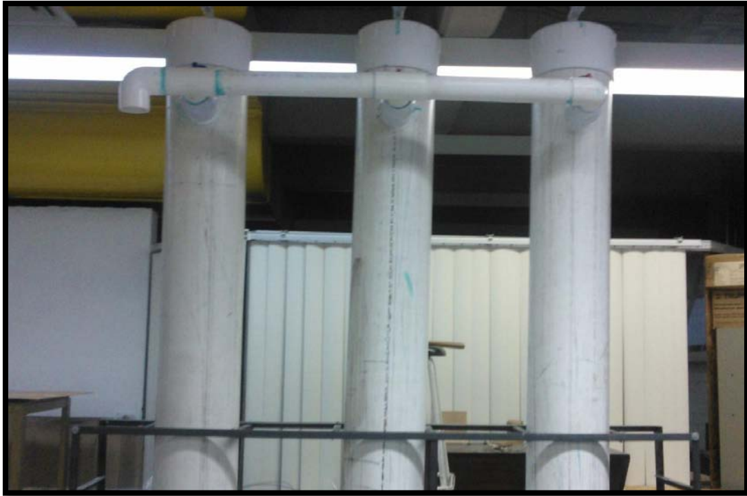
Figura 3.26 Instalación de la alimentación primera etapa. (Septiembre, 2014).
