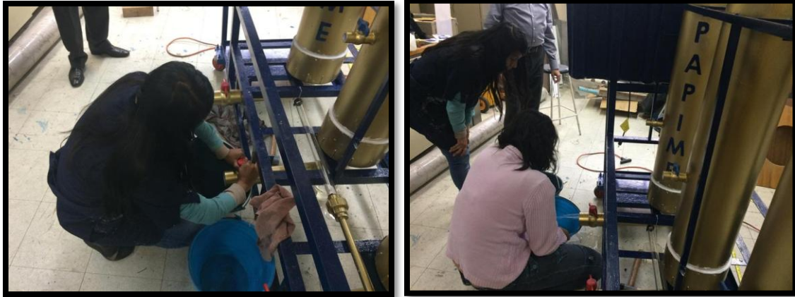
Figuras 3.51 y 3.52 Vaciado de las tuberías (Noviembre 2014).
