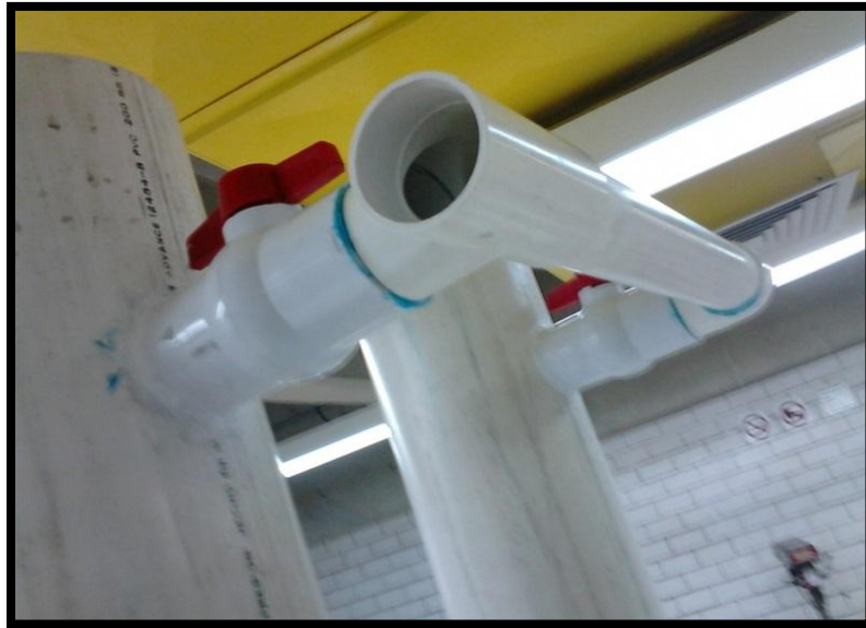
Figura 3.25 Primera conexión de la tubería de alimentación (Septiembre 2014)
