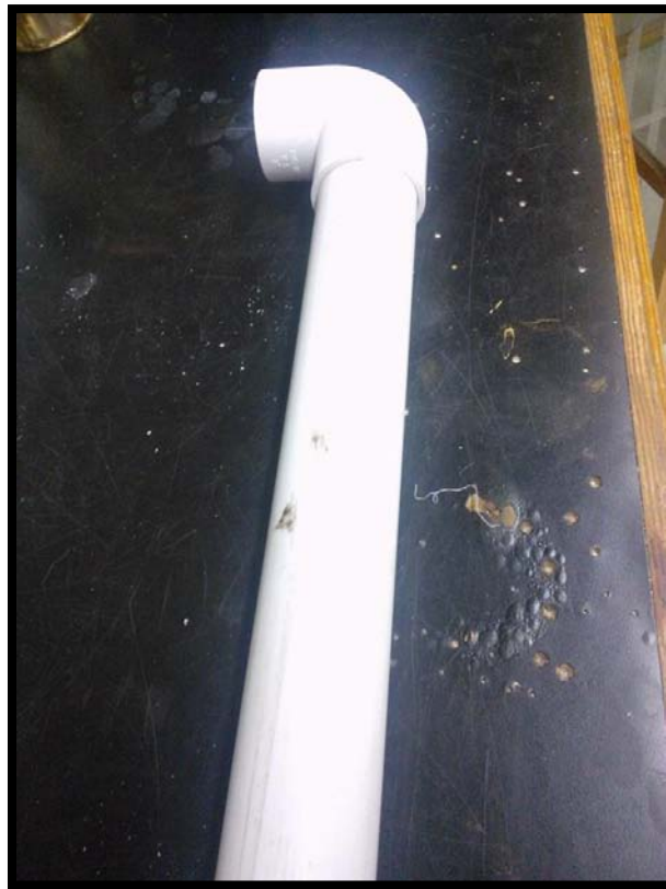
Figura 3.32. Tubo para la bajada de la alimentación (Septiembre, 2014).
