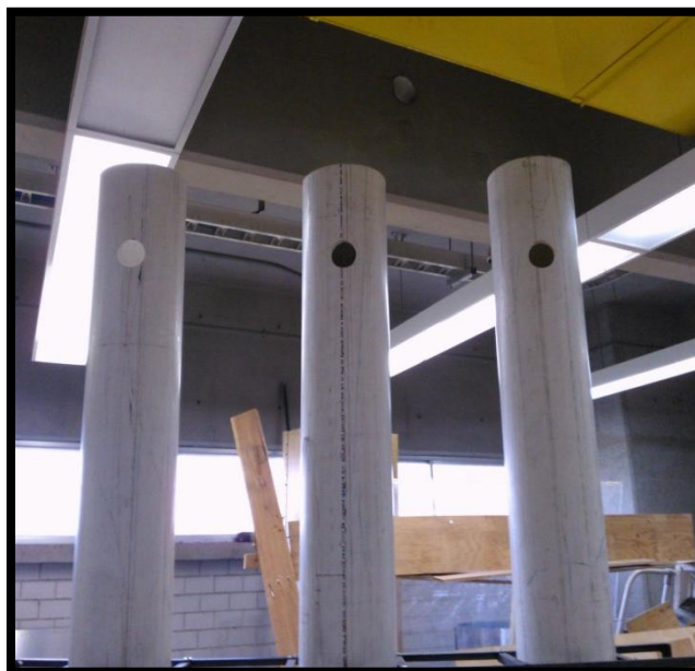
Figura 3.23. Perforaciones para la alimentación del biodigestor (Septiembre, 2014).
