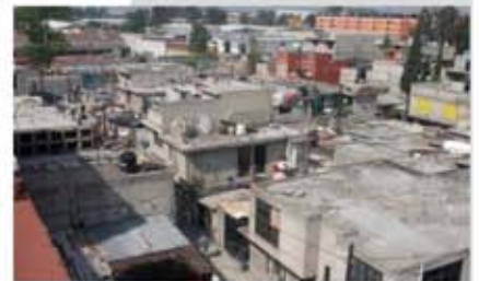
Construcción de vivienda de interés social.
