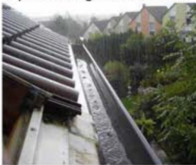
Recolección de agua de lluvias mediante la instalación de canaletas en techos
