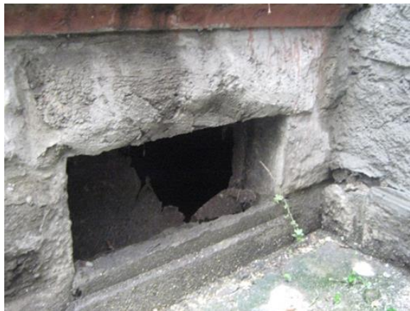
Imagen 50 casa 196 ventanas del semisótano, fotografía tomada por el Arq. José Antonio de Fuentes Reyes (2012)
