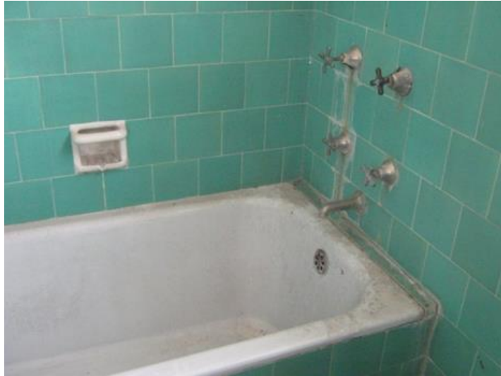
Imagen 46 baño de la casa 197 fotografía tomada por el Arq. José Antonio de Fuentes Reyes (2013)
