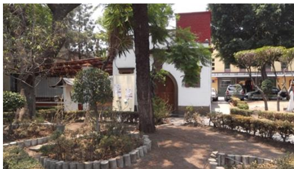
antiguo cuarto de bombas en el jardín Hidalgo
