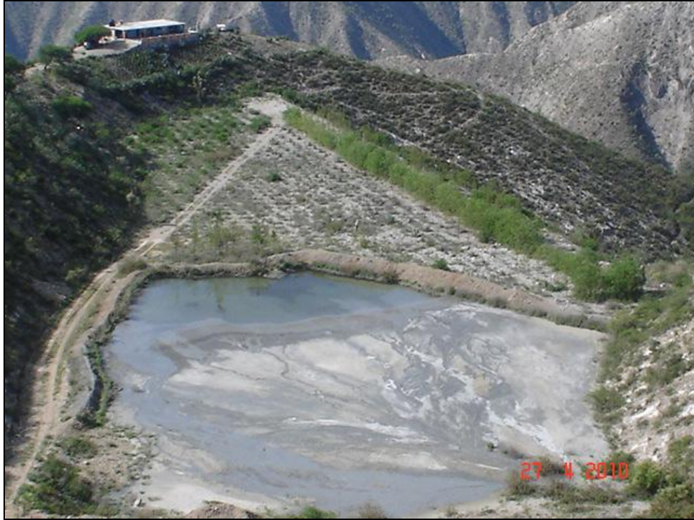
Figura 6 Talud y vaso de la presa 3
