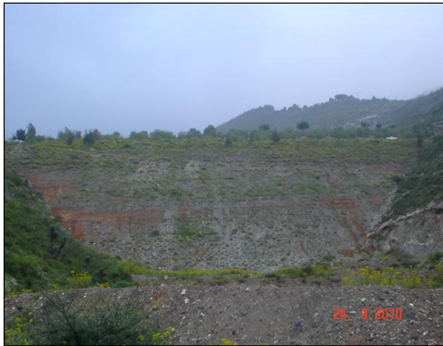
Figura 3 Talud de la presa 1 vista de frente
