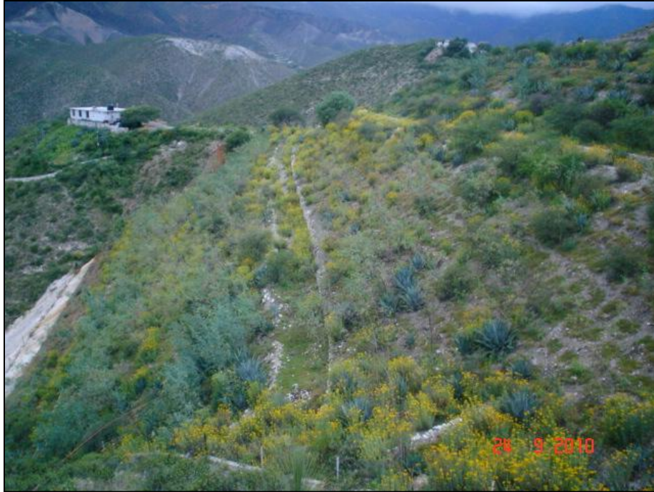
Figura 4 Talud de la presa 2
