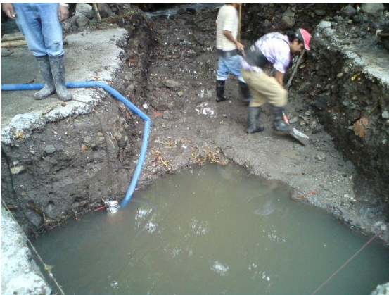
Foto 4.2.5 Excavación fosa y salida
