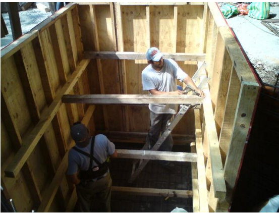
Foto 4.2.9 Cimbrado muros de fosa
