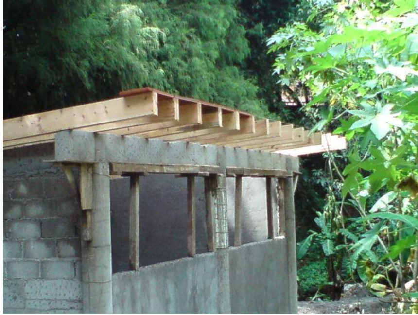
Foto A2-07 Vigas de madera de techo.
