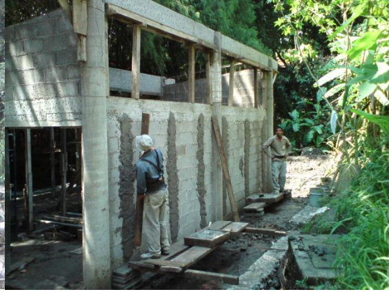
Foto 4.2.14 Trabes de cuarto de máquinas
