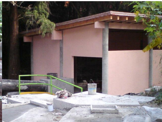
Foto 4.2.16 Cuarto de máquinas
