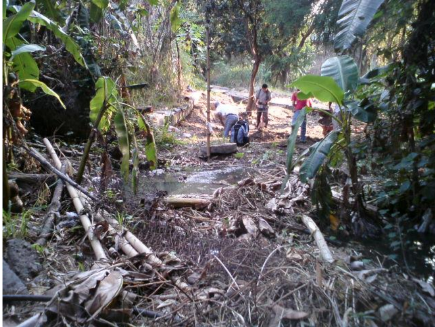
Foto A2-01 Vista de cortina y area de trabajo.
