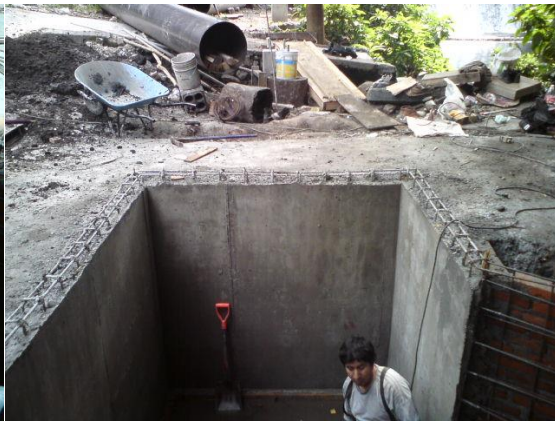
Foto 4.2.10 Muros de concreto en fosa
