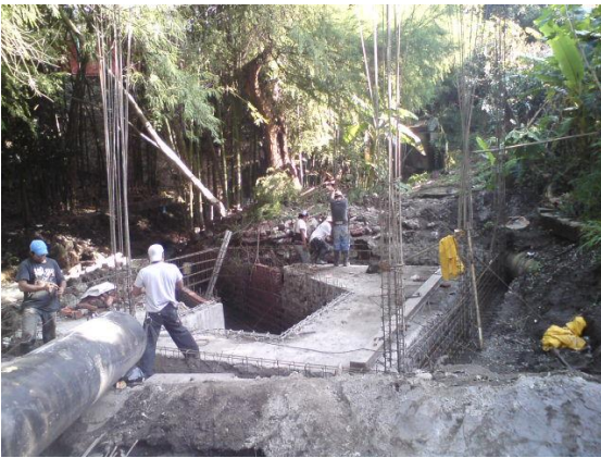
Foto 4.2.11 Armado de columnas
