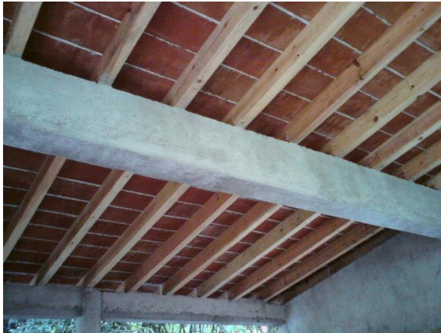
Foto A2-08 Vista de techo interior terminado.
