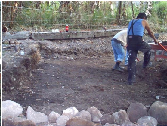
Foto 4.2.4 Excavación y nivelación piso
