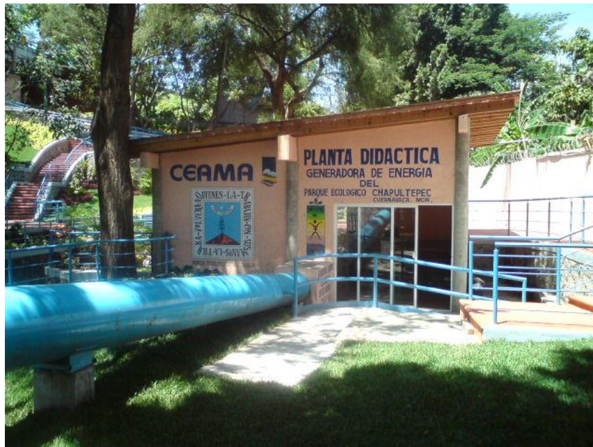
Foto A2-14 Vista exterior de cuarto de máquinas.
