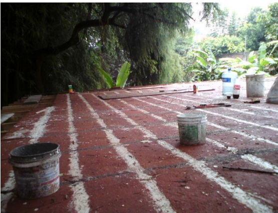
Foto 4.2.15 Celosía de losa
