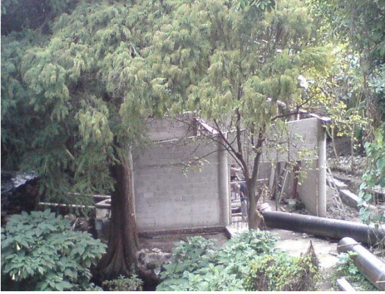
Foto 4.2.13 Muros de cuarto de máquinas
