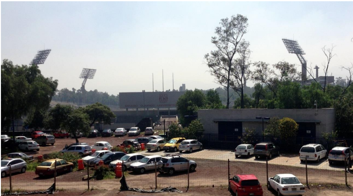
Fotografía 3. 1. Subestación General No. 6 y Estadio Olímpico Universitario.
