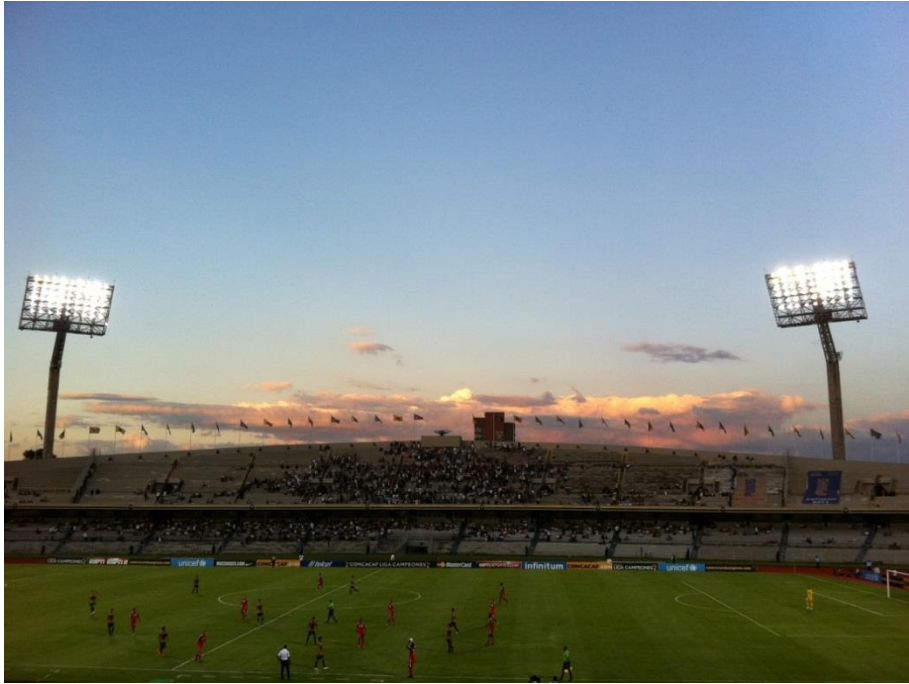
Fotografía 2. 2. Nuevo sistema de iluminación del Estadio Olímpico Universitario.
