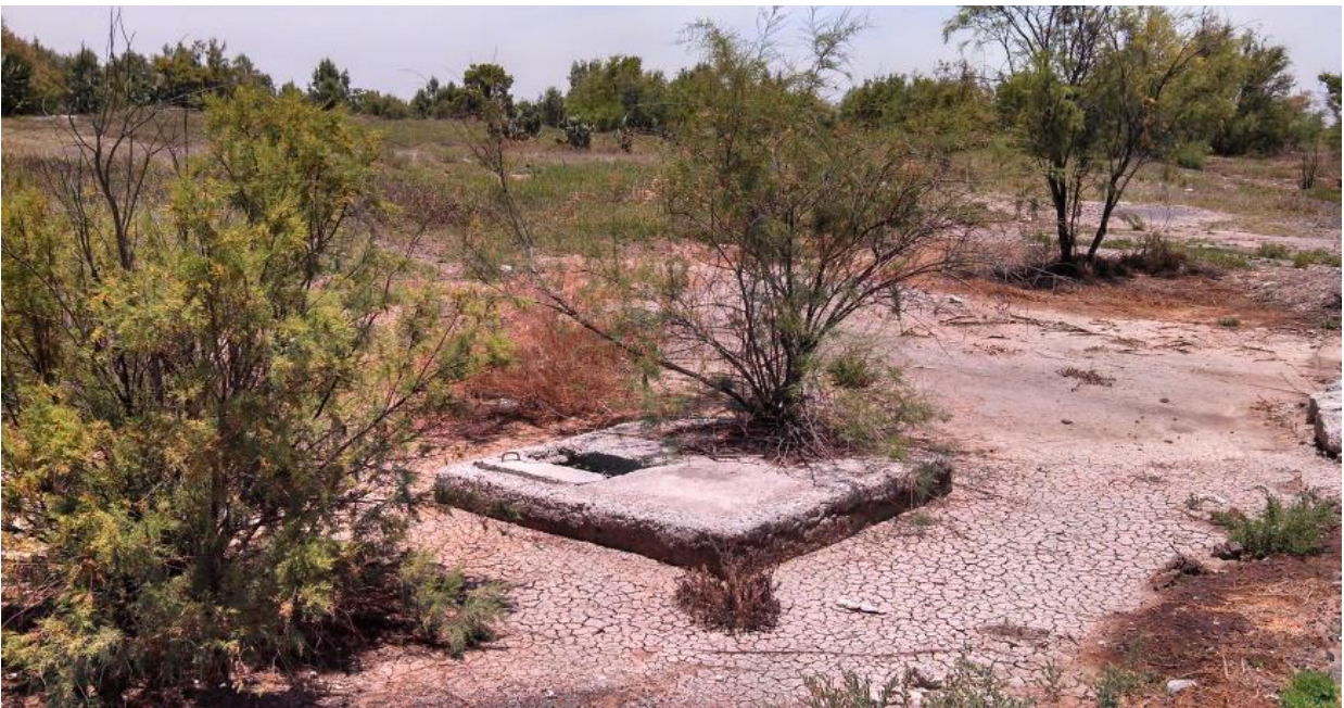
Figura 4-3. Pozo de extracción y monitoreo de lixiviado en la Etapa 3.
