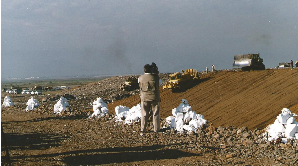
Figura 3-7. Conformación del talud en la Etapa 4.
