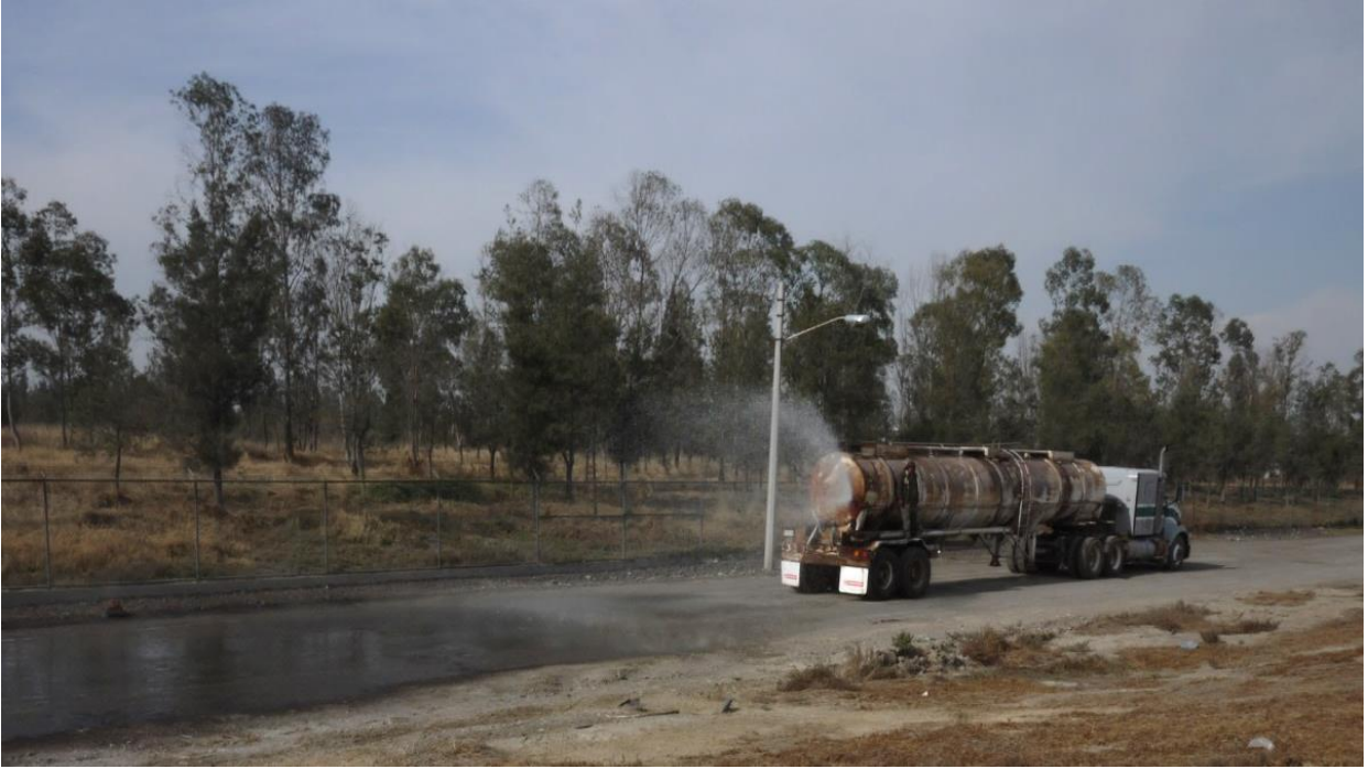
Figura 3-4. Riego de caminos para reducir tolvaneras.
