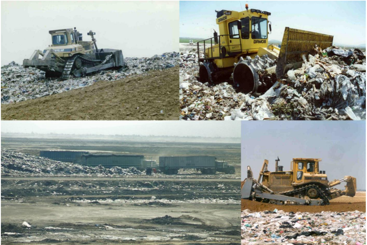
Figura 3-2. Operación en la Etapa 4, formación del talud, compactación, recepción y cubierta de los RSU.
