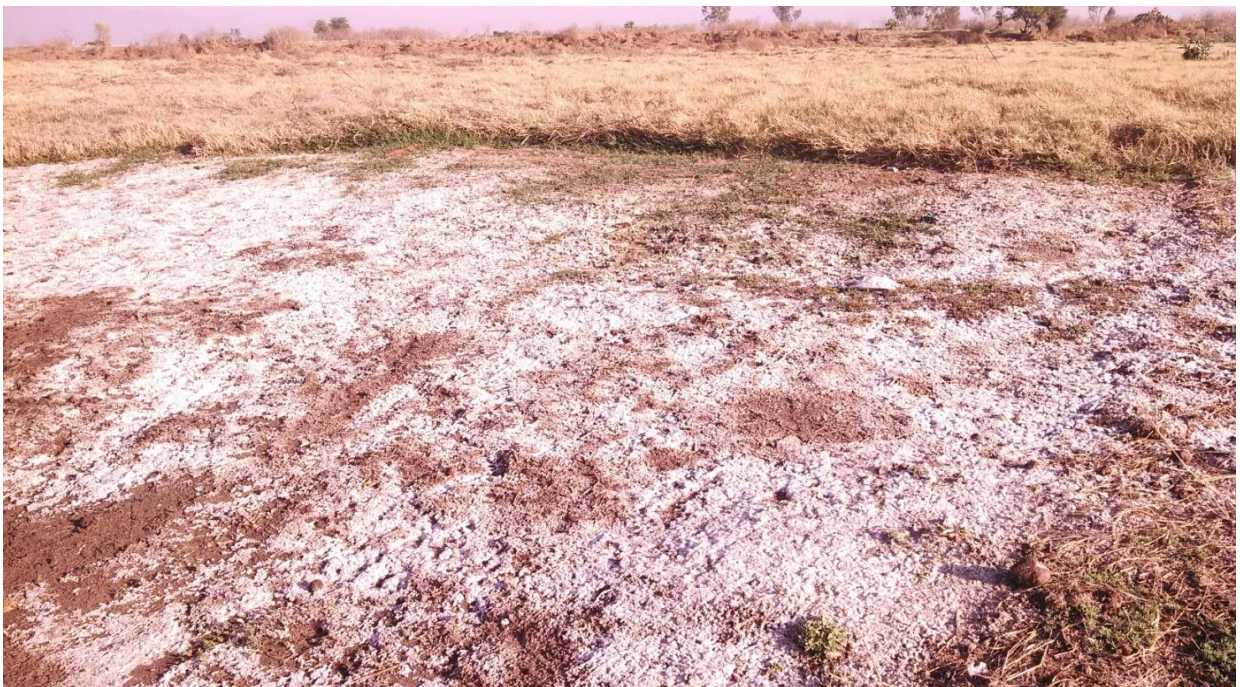
Figura 5-4. Sales que se generan en la superficie de la cubierta final de los desechos sólidos en la Etapa 1.
