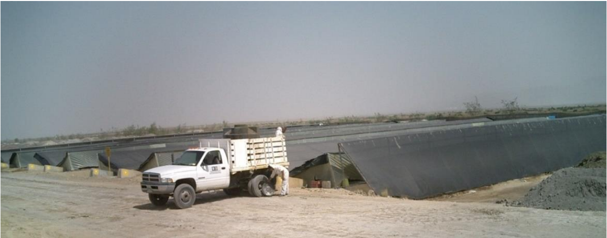
Figura 3-14. Tinas de evaporación de lixiviados en la Etapa 4.
