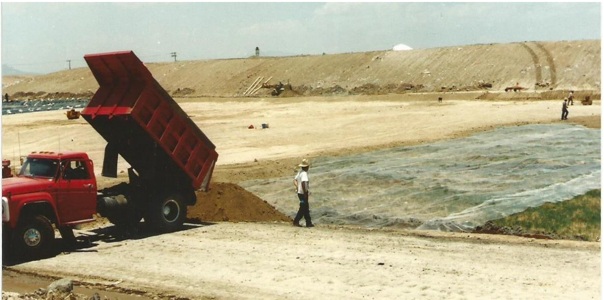
Figura 3-11. Protección de la geomembrana.
