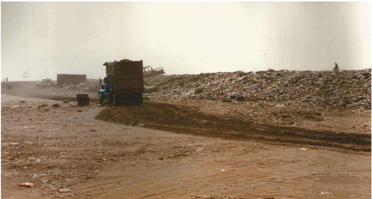
Figura 3-1. Operación del RSBP, recepción y cubierta de los RSU en la Etapa 1.
