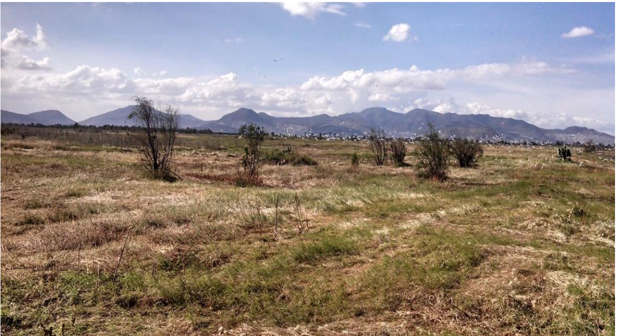
Figura 3-5. Vista de la cubierta final en la Etapa 2.
