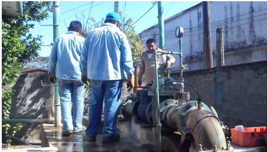
Vista de pozo de agua en la ciudad de Tepic.
