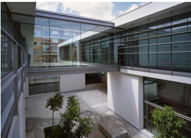
Puente de interconexión entre edificios.
