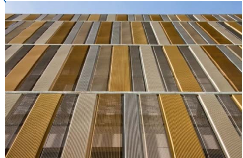
Paneles que constituyen una segunda fachada del edificio.
