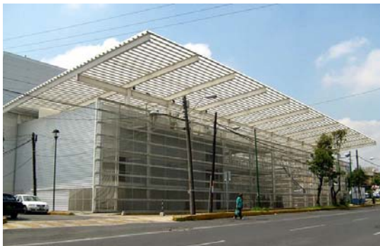
Fachada principal del CASU, constituida por rejas
