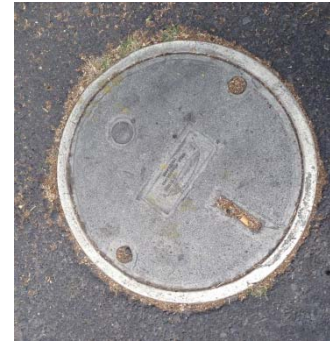
Registro de Red Telefónica
