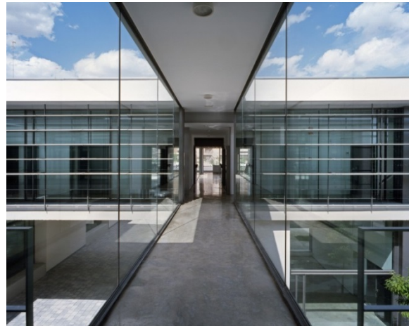
Puente de interconexión acristalado.
