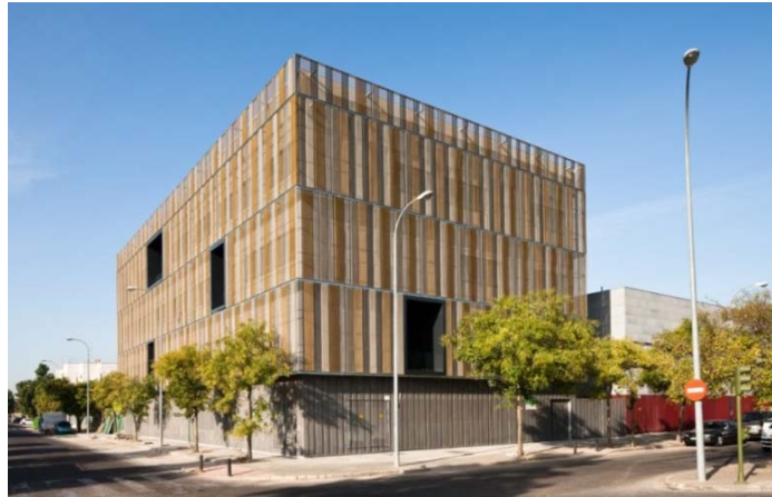
Fachada principal. Fuente archdaily.mx
