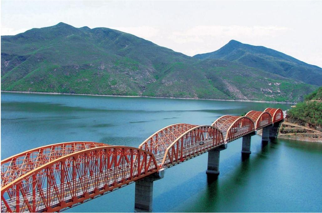
**Figura 1.2 Puente Infiernillo (armadura)**
