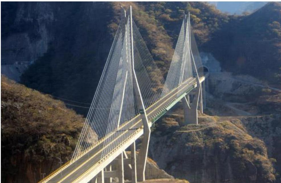
**Figura 1.1 Puente Baluarte (atirantado)**
