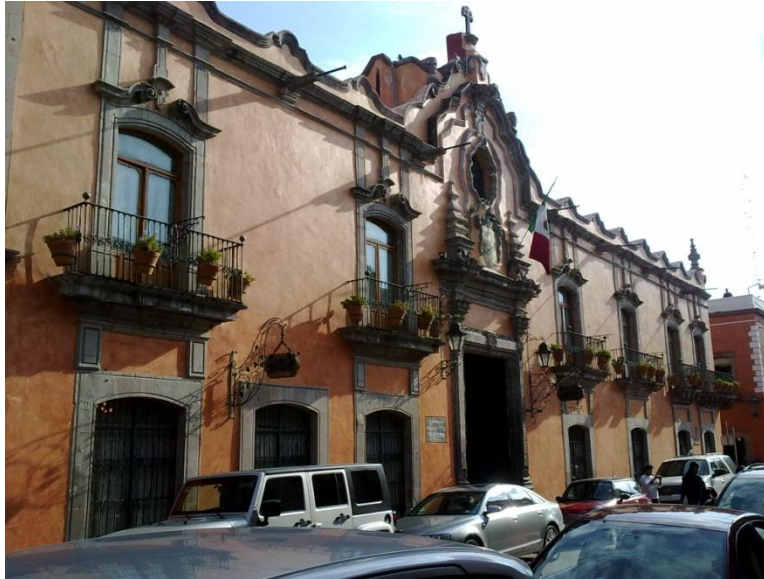
Hotel Casa de la Marquesa (GSH, 2012)
