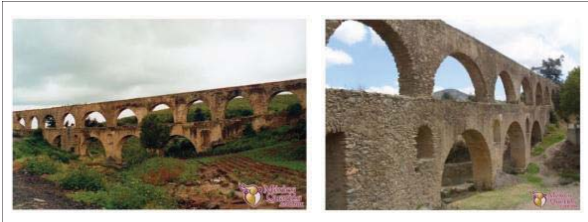
Figura 31.- Puente virreinal y Antiguo Acueducto de Chalchicomula de Sesma (Fuente:mexicoquerido.mx)
