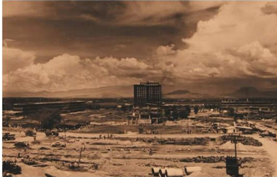
Imagen 2.2 “Construcción de C.U”
