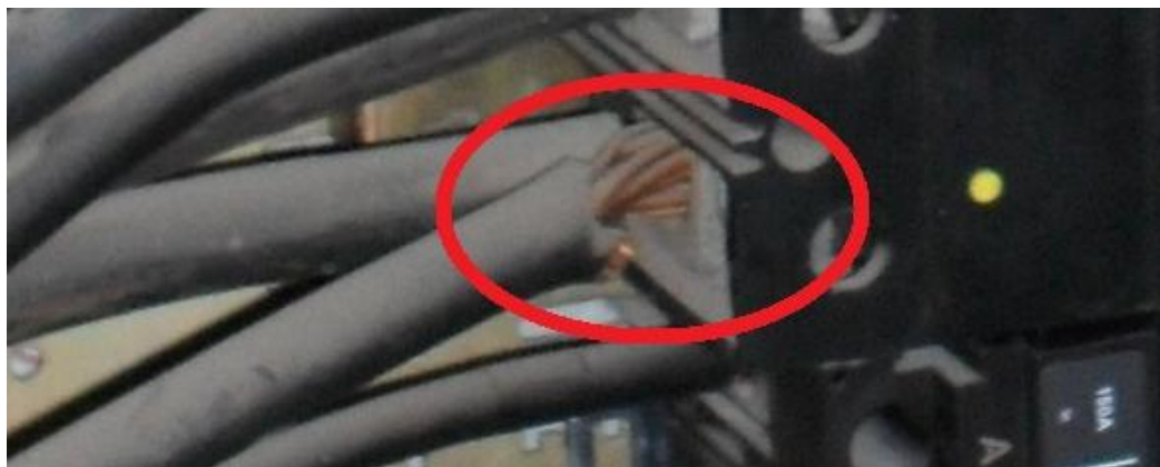
Imagen 2.13 Conductores capados
