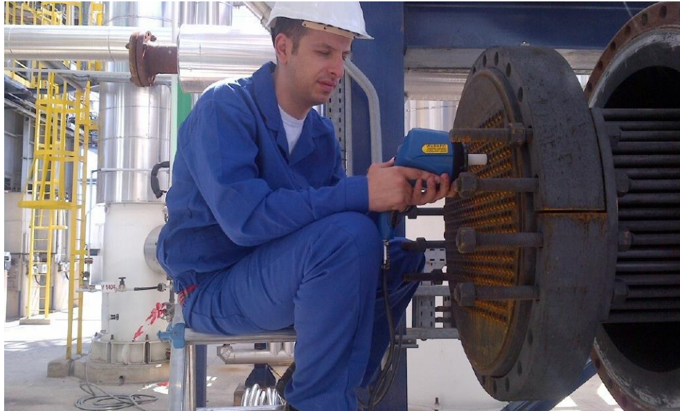
Figura 2.26. Mantenimiento de un intercambiador de tubos y coraza (cortesía de PROMMENT Maintenance & Industrial services).
