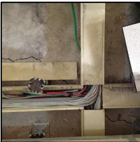
Figura 2. 8 Unión de canaletas en piso falso
