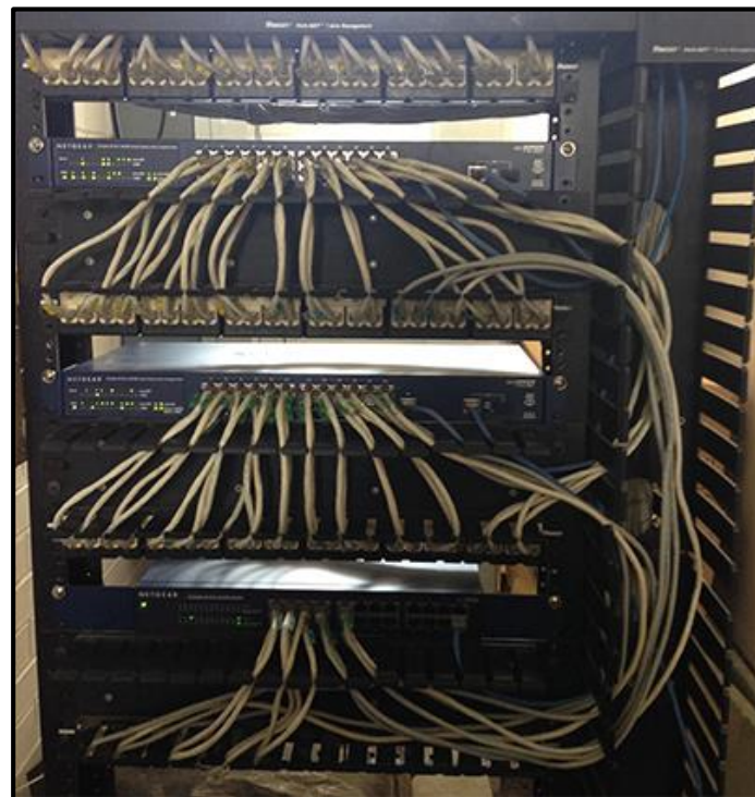
Figura 6. 5 Instalación del cuarto switch
