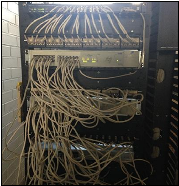
Figura 6. 2 Instalación del primer switch
