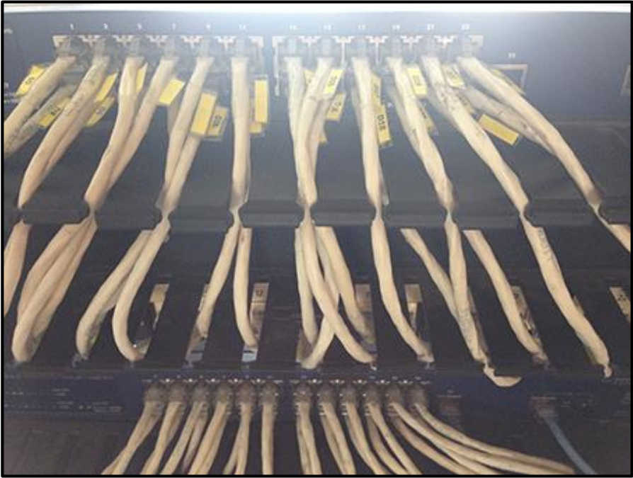
Figura 6. 6 Etiquetado de conexiones del primer switch
