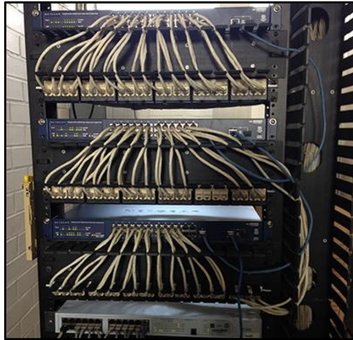
Figura 6. 4 Instalación del tercer switch
