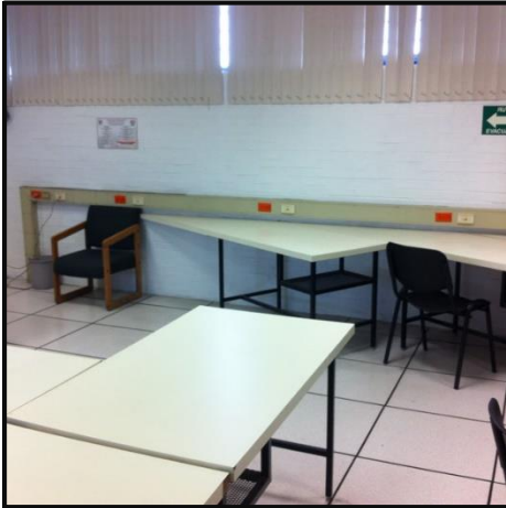
Figura 2. 4 Canaleta expuesta de área de trabajo
