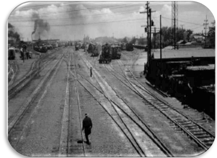
Figura 1. Patio de inspección de estación Buenavista
