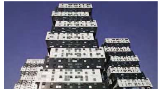
IMAGEN 20/Complejo habitacional Bumps, Beijing, China de la firma japonesa SAKO Architects 2008.
