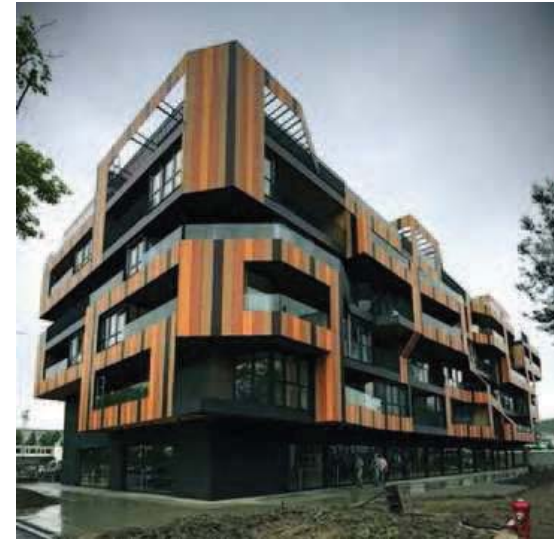
IMAGEN 19/Vivienda colectiva en Nova Gorica, Eslovenia de la firma OFIS arhitekti 2007.
