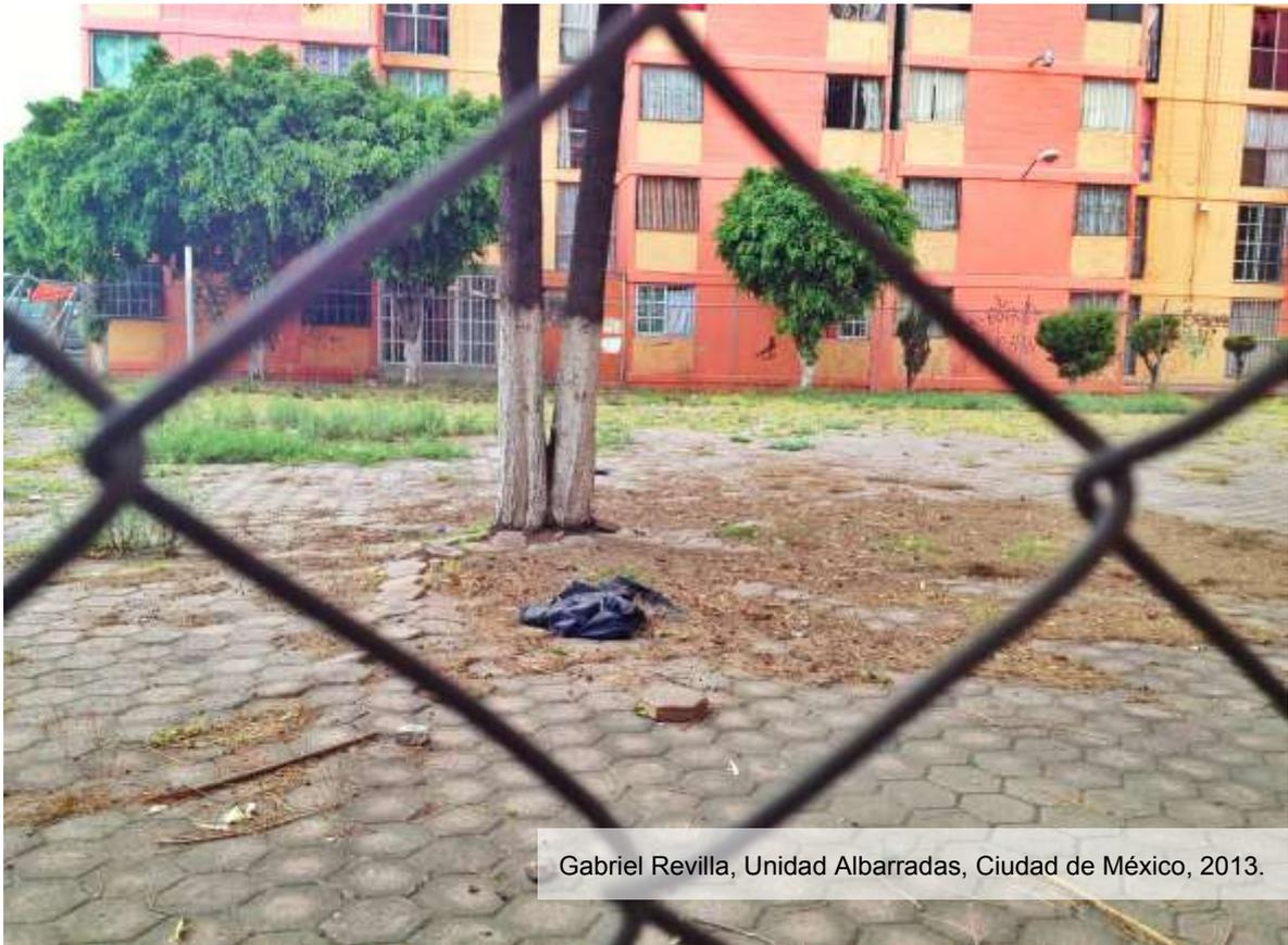
Figura 4.51. Las raíces de los árboles se abren paso a través del adoquín que el usuario colocó a fin de que no fuese utilizado como cancha de fútbol por los niños del lugar. En primer plano, la reja que impide el acceso.
