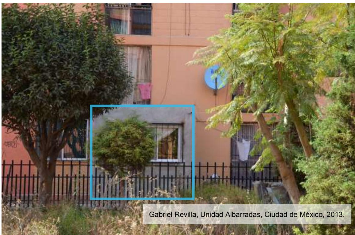
Fig. 4.21. Una de las alternativas al observar el hueco de nadie: alargar la sala comedor y así ganar algunos metros cuadrados. En este caso sólo un departamento ha crecido, enmarcado en azul se señala la invasión parcial del remetimiento del edificio, en este caso, elaborada en concreto armado.
