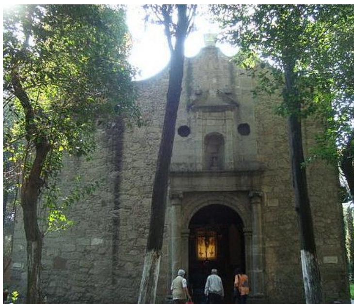
Fig. 18. Vista actual de la fachada de la Parroquia de Santa María Nativitas
