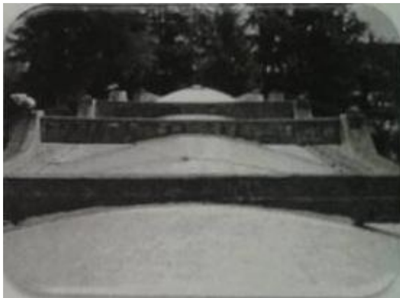
Fig. 20. La bóveda de cañón corrido construida de concreto reforzado sustituyó una techumbre de bóveda catalana en 1950 (Gutiérrez, 2011)
