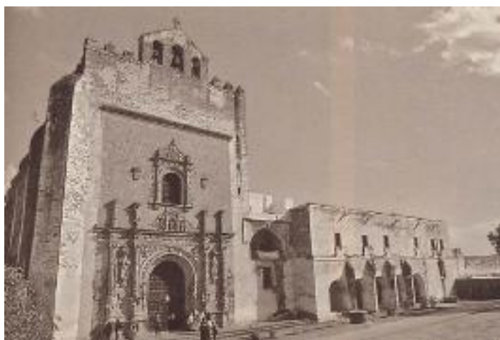
Fig. 8. Componentes típicos de una fachada de un templo conventual: Portada, espadaña, capilla abierta y portería (Acolmán, Estado de México) (Meli, 2011)
