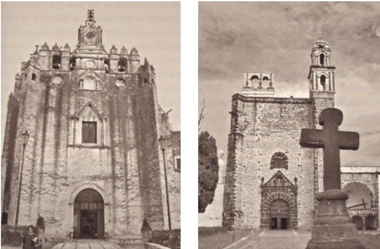
Fig. 9. Fachadas con contrafuertes diagonales (Atlatlahuacan, Morelos; Tochimilco, Puebla) (Meli, 2011)
