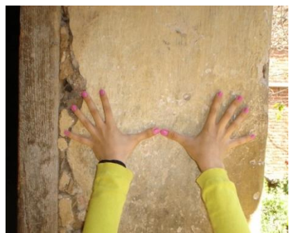
Muro de los lavaderos hecho de adobe. Casa Hidalgo #120
