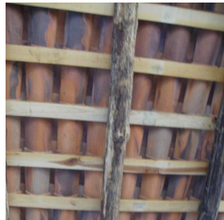
Techo de teja Foto: Francisco Preciado 2009
