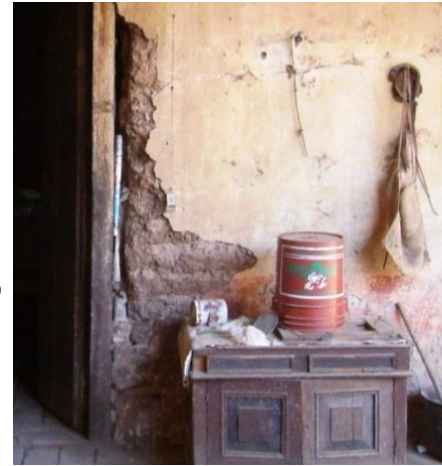
Muro de la cocina. Casa Hidalgo #120 Foto: Cintia Preciado 2011
