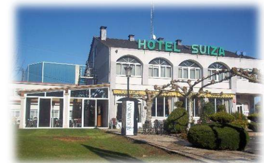
Imagen 11. Hotel Suiza de carretera Arzúa, España
