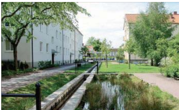
Figura 5-3. Sistema de canales y estanques en Augustenborg, Suecia. Fuente: archi-europe.com
