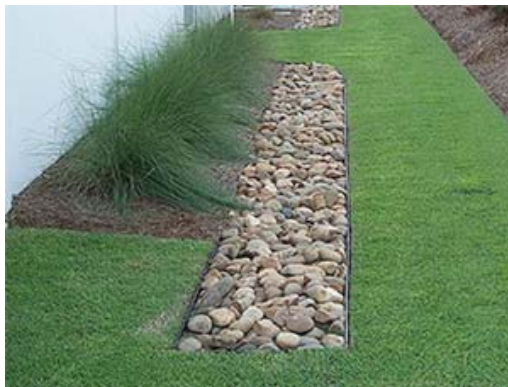
Figura 3-7. Zanja de infiltración. Fuente: sudswales.com
