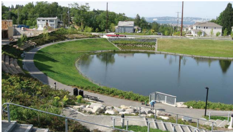
Figura 3-14. Estanque de retención. Fuente: drenajeurbanosostenible.org
