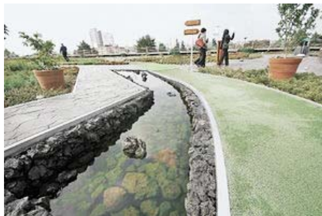
Figura 5-8. Azotea verde del edificio del INFONAVIT. Fuente: eluniversal.com
