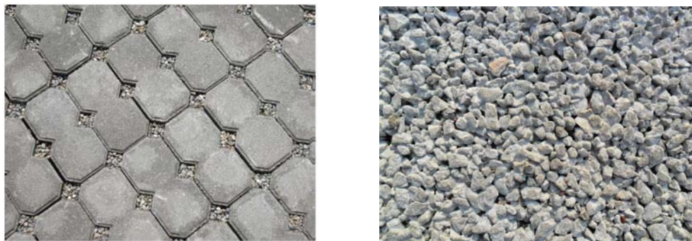
Figura 3-6. Pavimento poroso (derecha) y pavimento permeable (Izquierda). Fuente: boletin-iccy.com y hidrocreto.com
