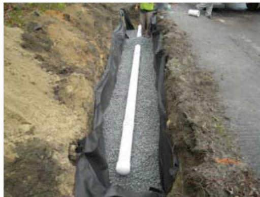
Figura 3-9. Dren filtrante o francés. Fuente: satuitcon.com
