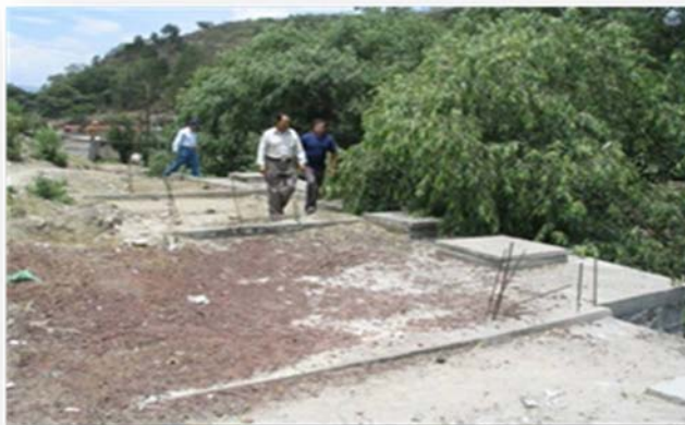
Figuras 13. Contenedor de concreto de aguas negras y pluviales Río Esclavo.
