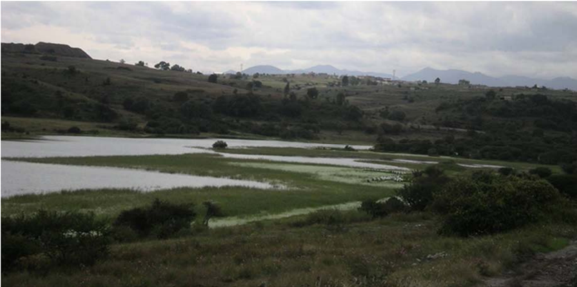
Figura 11. Imagen de la Presa El Rosario.
